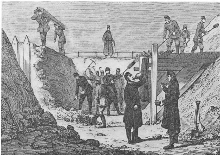
Skansearbejde på Dybbøl. Skanserne var ved krigens udbrud slet ikke udbyggede i henhold til planerne, og først i løbet af februar blev skanserne udbedret af de danske soldater. (Træsnit fra Illustreret Tidende 1864).
