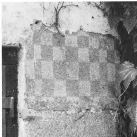
»Skæktavl-behugget« kvader fra soklen på den vestlige, af Kong Frederik IV tilbyggede, fløj af Clausholm.
