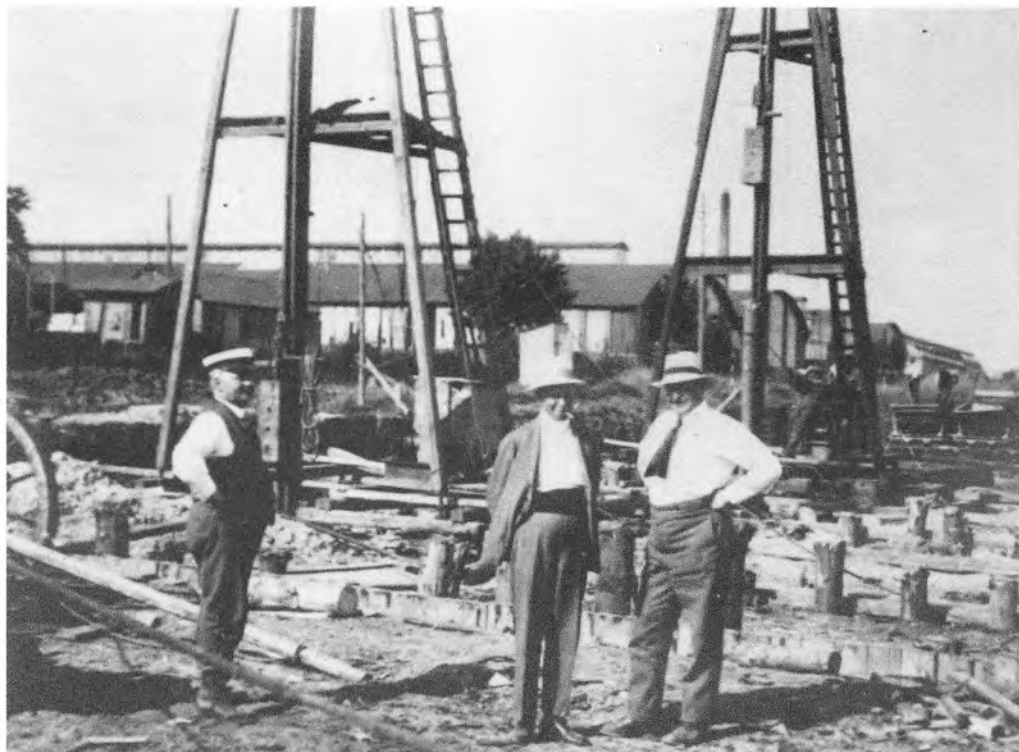
Etablering af rensningsanlægget ved Scandia, 1922. Stadsingeniør Rich. Kromann (m.f.), tømrermester Jens Wellew (t.v.) og en unavngiven ingeniør inspicerer piloteringsarbejdet. (Foto: Randers Lokalhistoriske Arkiv).
