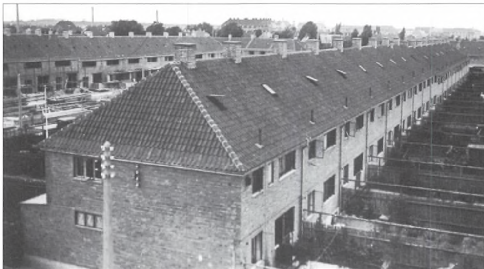
Husene på Drosselvej og den vestlige side af Fuglebakkevej blev bygget til sidst. Her ses de under opførelse
