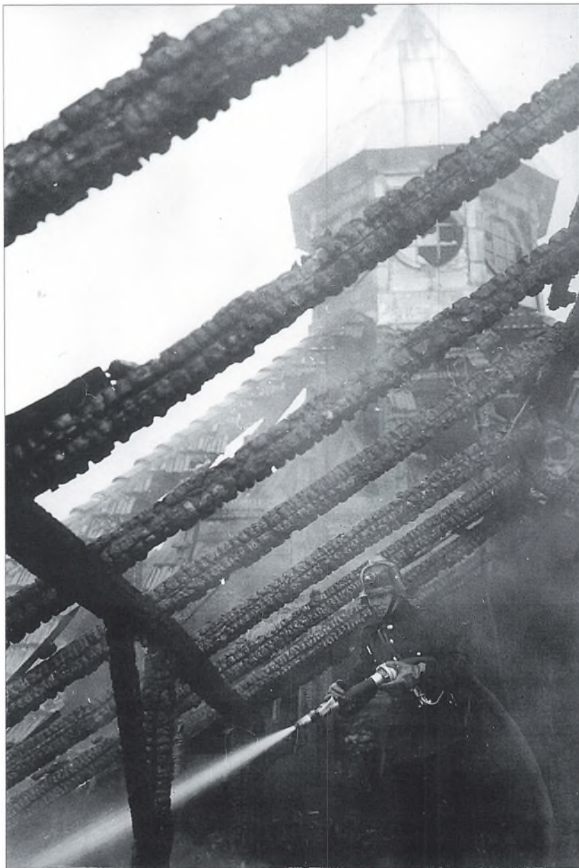
Brandmand bekæmper ilden på tagetagen på Sct. Maria Hospital. Bagved ses tårnet, der ligesom den øverste etage blev ombygget. Fotografi i privat eje.
