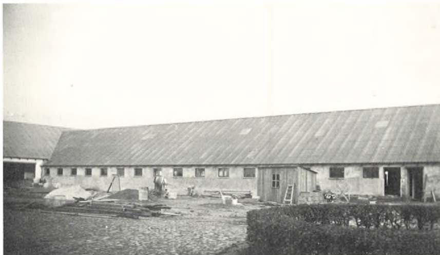
Kostalden under opførelse. 1958.
