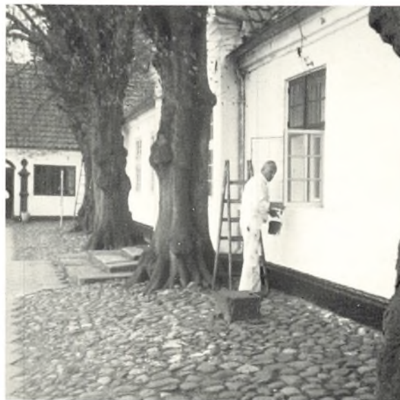
De nye vinduer males.
