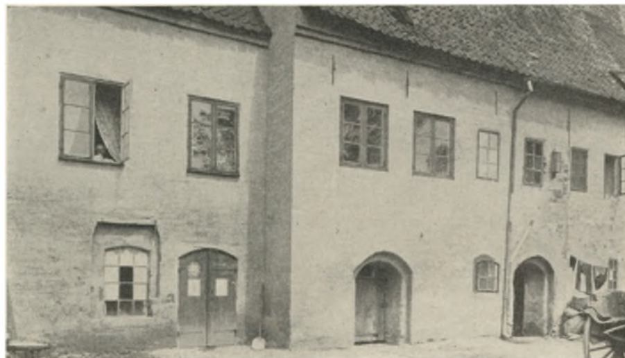
Sydsiden af Mogens Thuesens Stenboder og Henrik Gotschalks Hus.
