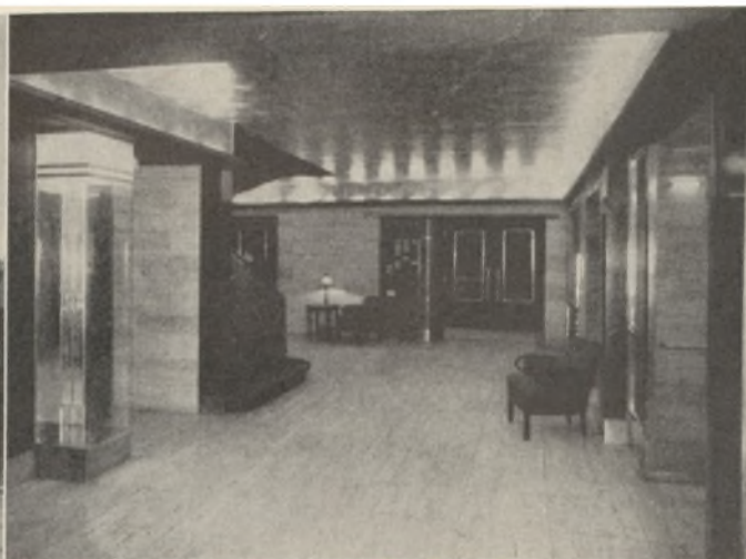
Interiør fra den nyrestaurerede Forhal.
