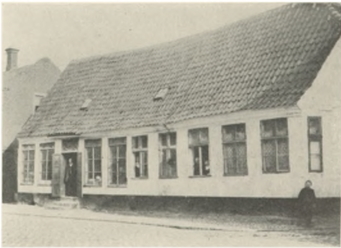
Købmand Daases Ejendom i Ringstedgade før Ombygningen. Opført 1734.
