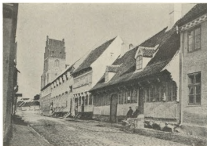
Apostelgaarden før Restaureringen i Riddergade fra ca. 1500. Paa Stolperne findes Egetræsknægte med udskaarne Figurer, forestillende Kristus og de 12 Apostle, tilvenstre en smuk toetages Bindingsværksbygning fra det 17. Aarhundrede.
