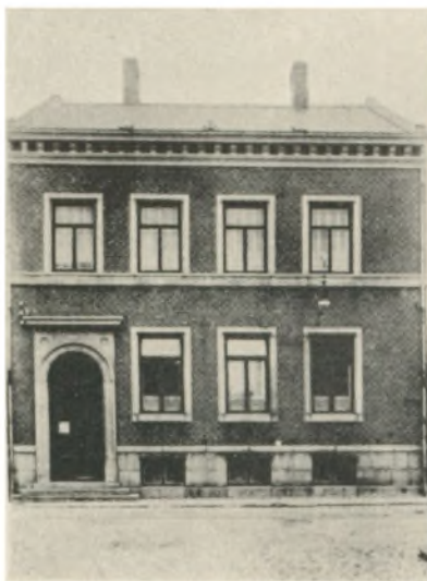
Bankens Bygning i Ramsherredgade.
