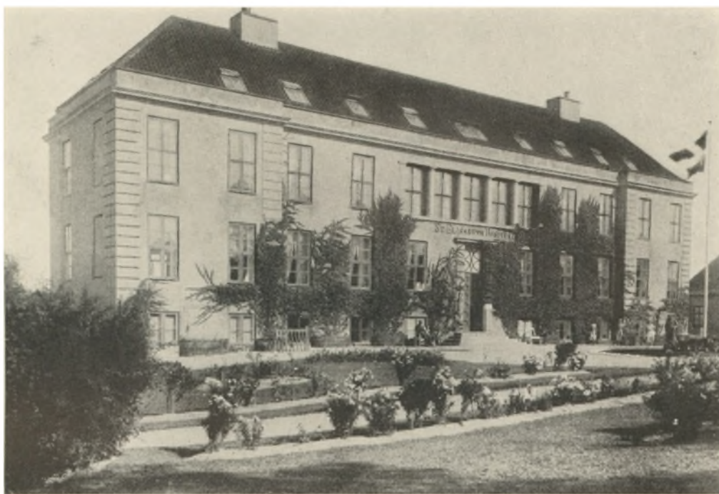
Hospitalsbygningen set fra Præstøvejen. Den i Efteraaret 1934 paabegyndte Opførelse af en betydelig Tilbygning af Hospitalet vil være afsluttet i Foraaret 1935.
