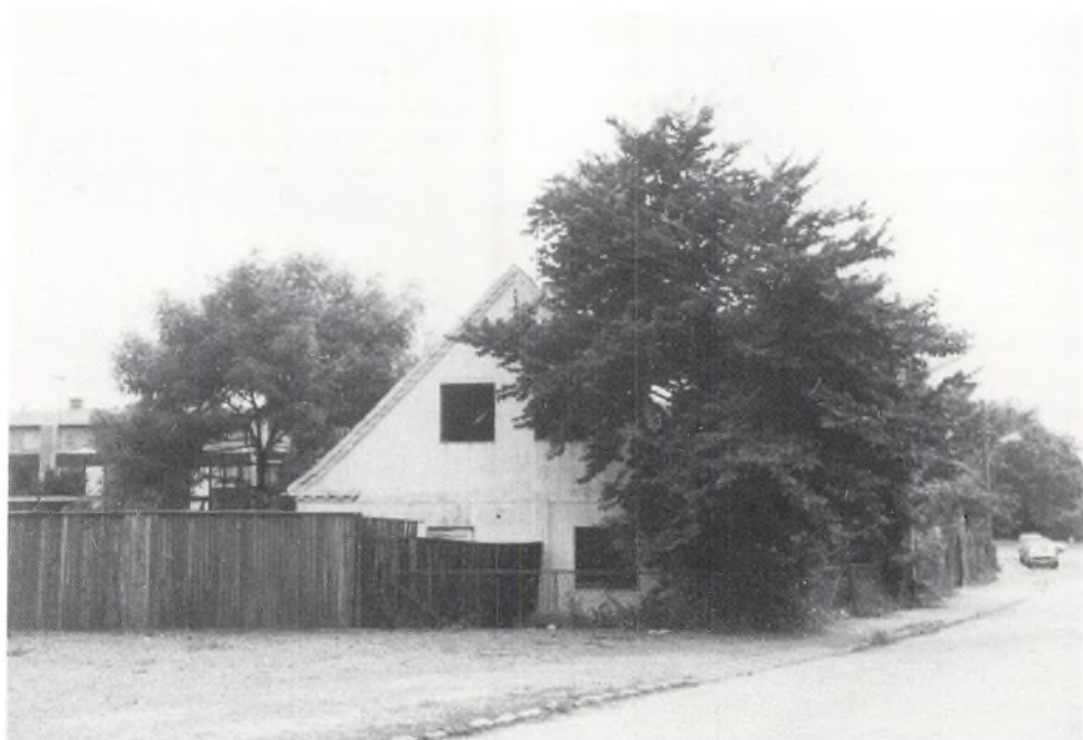
Langagervej matr. nr. 13b, huset, som Ole Jørgensen byggede efter branden. Senere kaldet Gartnerhuset. Nedrevet 1981. Foto 1980. NVN.
