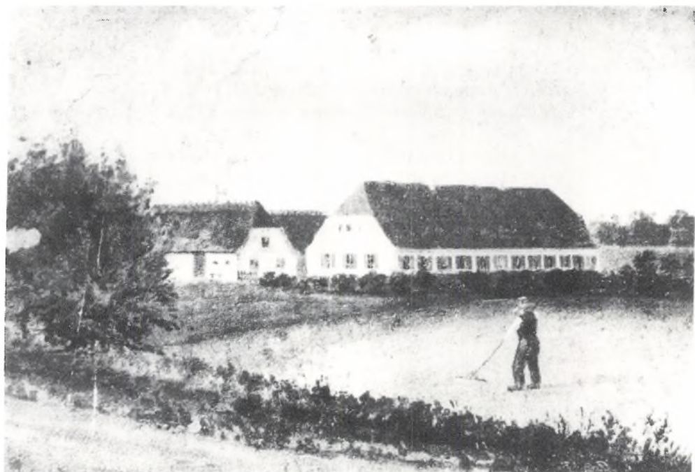
Vægmaleri af Harrestrupgård efter 1854, fundet på et panel under restaurering af en af de mange lejligheder, der senere blev indrettet dels i de store udlænger til gården, dels ved at bygge endnu en etage ovenpå.
