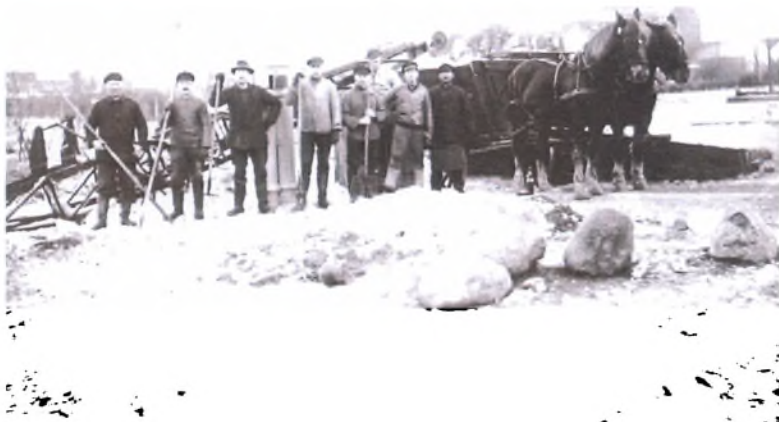
Arbejdsholdet med den særprægede opgave er fotograferet i 1926 Husene bagest midt i billedet ligger på Damgade
