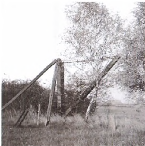
Kranen i Stenholt
