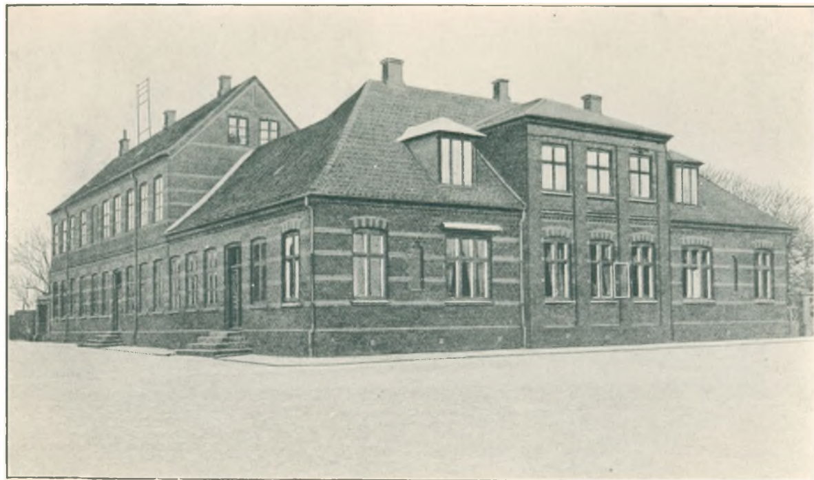
DEN GAMLE KONTORBYGNING OG DIREKTØRBOLIG
