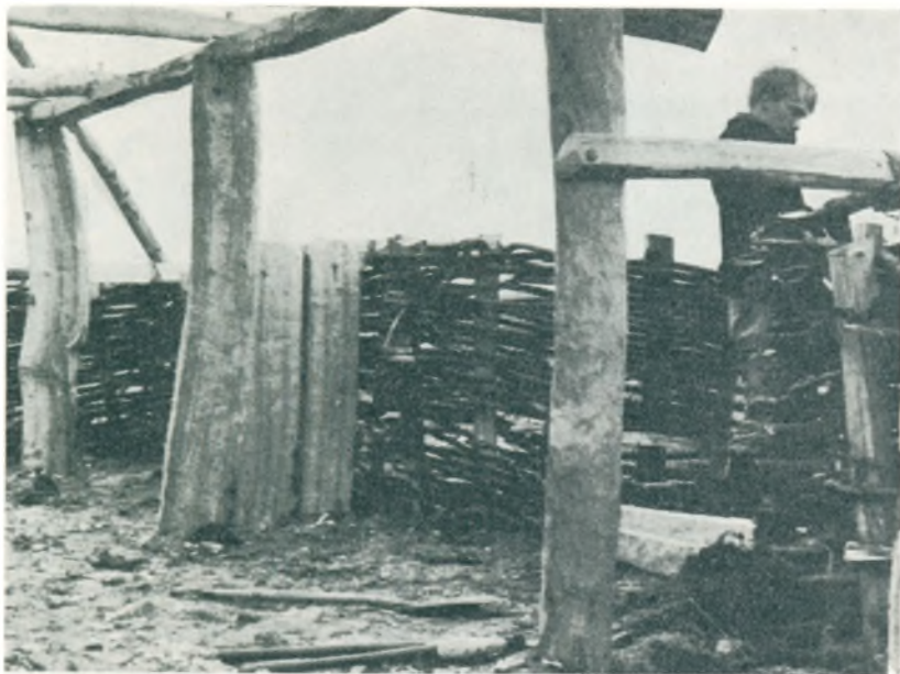
Fig. 7. Stolper og fletværk til jernalderhus. Fra rekonstruktionsarbejdet i Historisk-Arkæologisk Forsøgscenter i Lejre.
