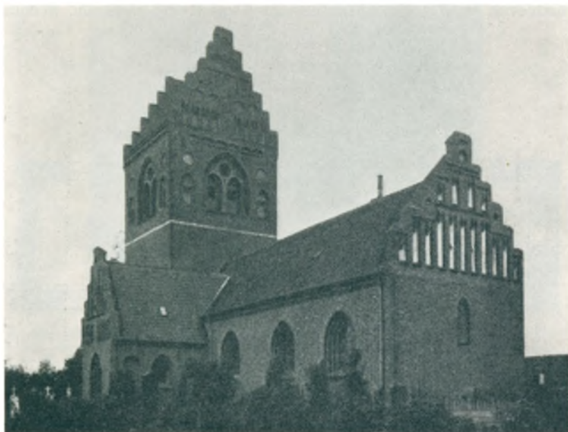
Fig. 18. Glostrup kirke set fra sydøst. Ved en stor restaurering i 1873—74 blev skibets langsider skalmuret med røde teglsten, vinduerne ændret og våbenhuset helt ombygget.
