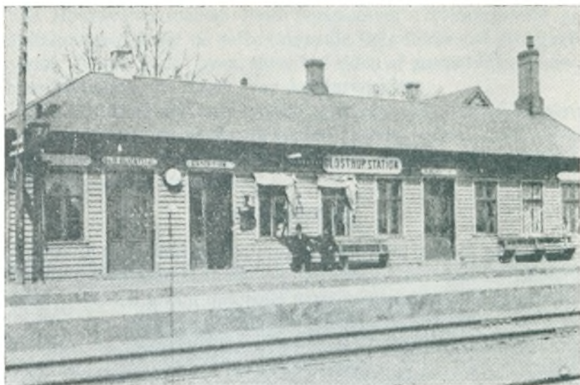
Fig. 2. Glostrups gamle jernbanestation. Foruden kontor og billetsalg rummede bygningen både 2. og 3. classes ventesal samt et såkaldt dameværelse, hvis fornemste pryde var et rigtigt gammeldags »das- skjult bag et grønt forhæng.
