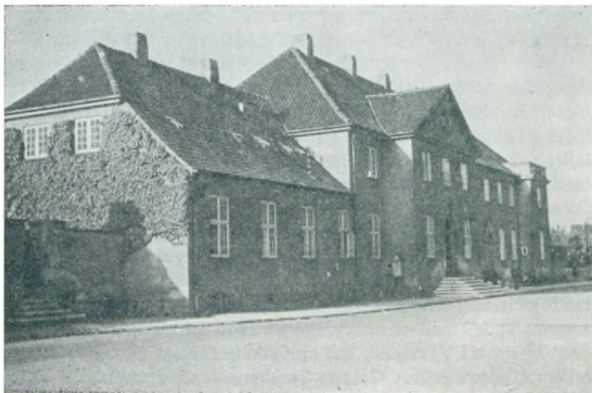
Fig. 3. Glostrups nye jernbanestation. Opført 1918.
