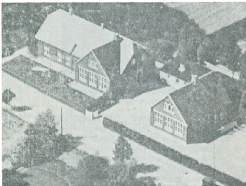
Fig. 50. Hvissinge skole. Til venstre ses den første skolebygning med lærerboligen, opført 1913; til højre annekset med lærerindebolig, opført 1923.
