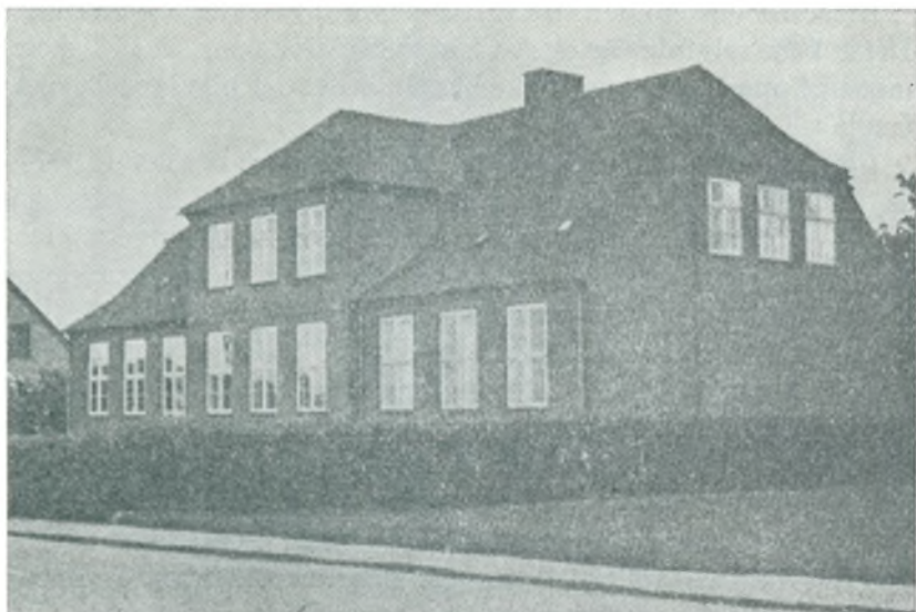
Fig. 56. Avedøre tredje skole, opført 1929.
