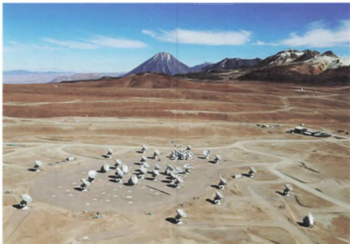
Billede af ALMA observatoriet under opbygning i 5 kilometers højde på Chajnantor plateauet i Atacama ørkenen i Chile. De store 12 meter antenner ses spredt udover den nederste halvdel af billedet og de mindre 7 meter antenner i en lille gruppe lige under midten af billedet. Ude til højre ses nogle af kontrolbygningerne for ALMA. Billedet blev taget i December 2012, fire måneder før ALMA blev indviet. (Image credit: Clem & Adri Bacri-Normier (wingsforscience.com)/ESO)
