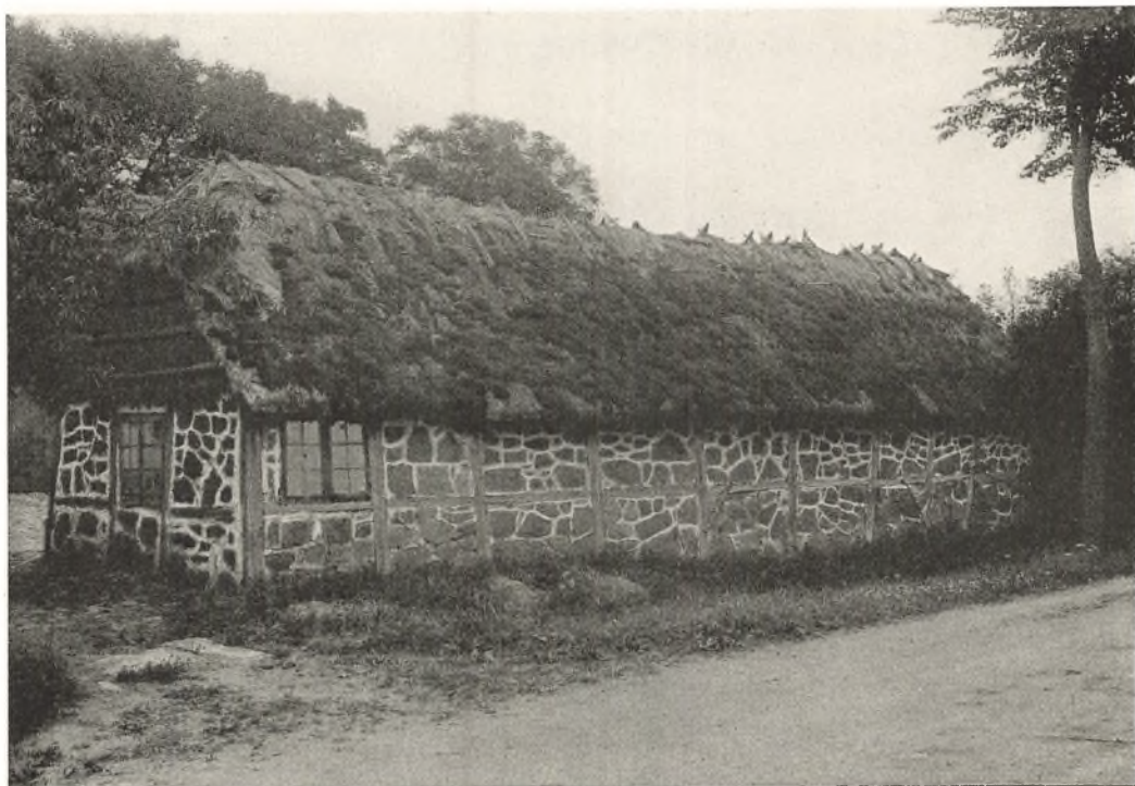
53. Bindingsværk med Kampesten i Tavlene.
