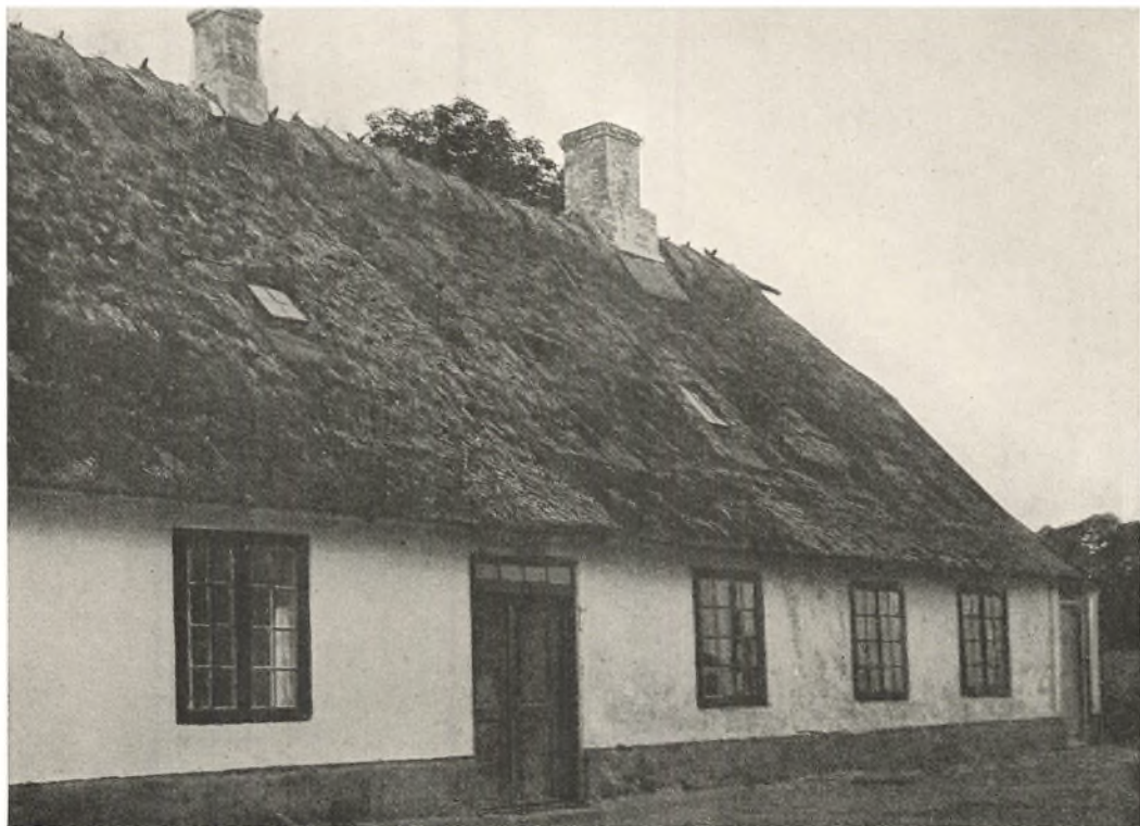
55. Bygning opført af jordstampede overkalkede Vægge.
