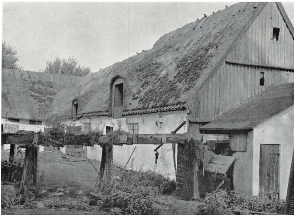
Elverdams Vandmølle. Bemærk den gamle trærende, som fører vandet til hjulet. (360)
