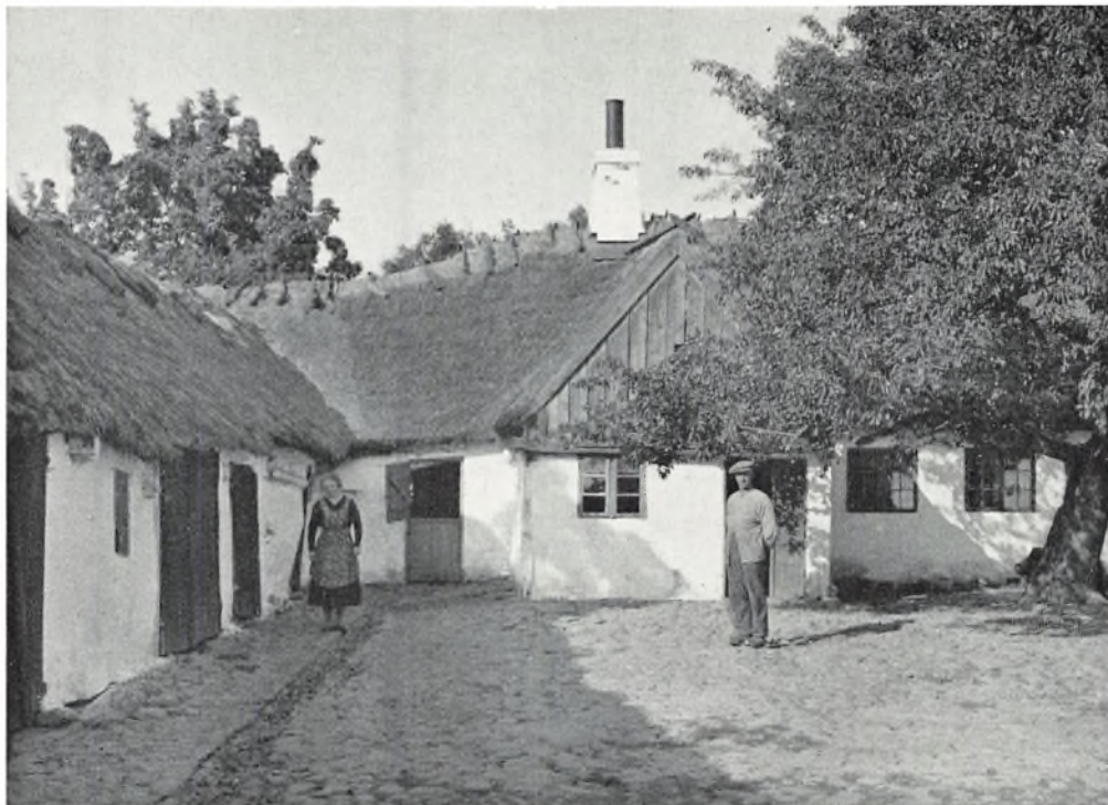
Ellemosegård i Vejleby ved Hørve, set fra gårdspladsen. Bemærk bislaget på stuehuset. (297)
