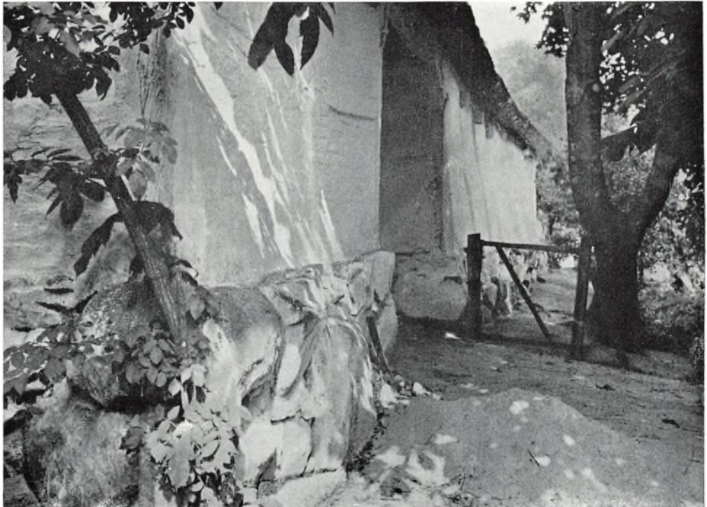
Ydervæg af sydlige længe af den gamle gård i Hjelmsømagle. (194)
