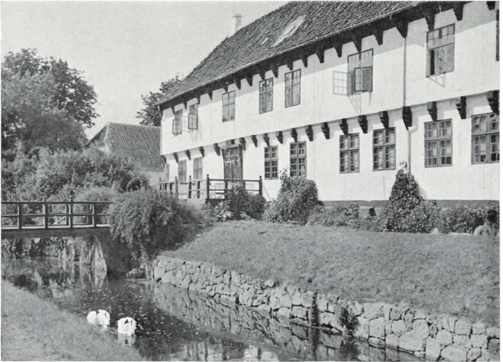
Rudbjerggårds hovedbygning og slotsgraven, set fra parken. (350)
