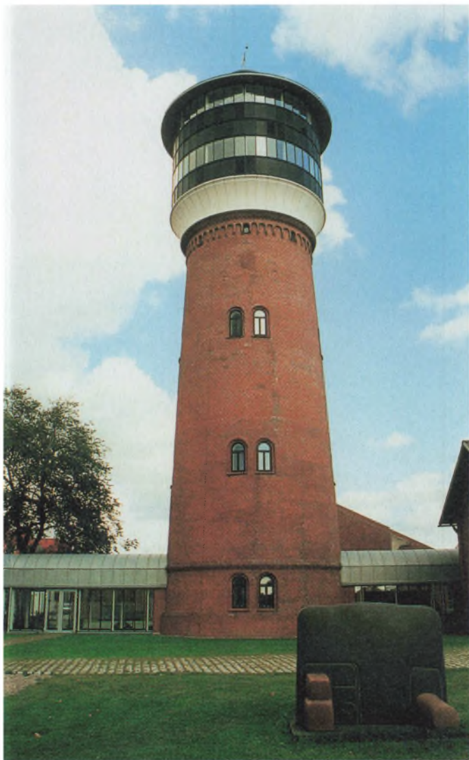
Vandtårnet i Tønder fra 1902 ombygget til udstillingstårn i 1995 af MAA Niels
