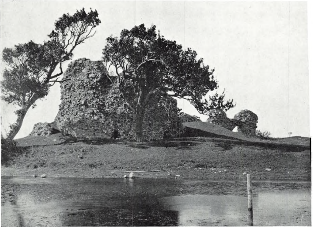
SLOTØ. Borgruinen set fra syd. I baggrunden til højre den østligste af de divergerende mure. Til venstre resterne af den lille ydermur. (281)
