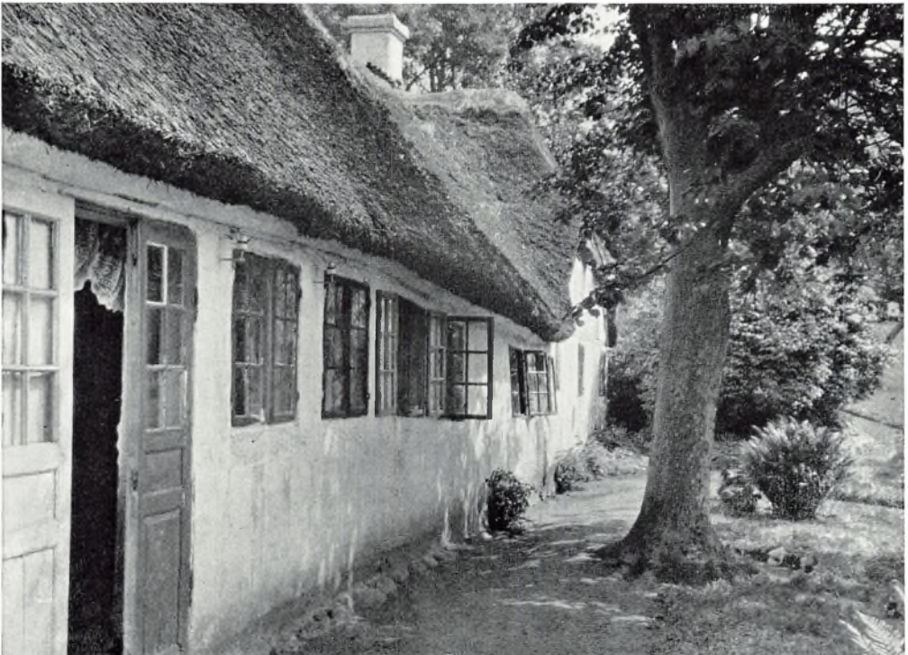
Skvæt Mølle ved Skanderborg. Stuehusets facade mod haven. (222)
