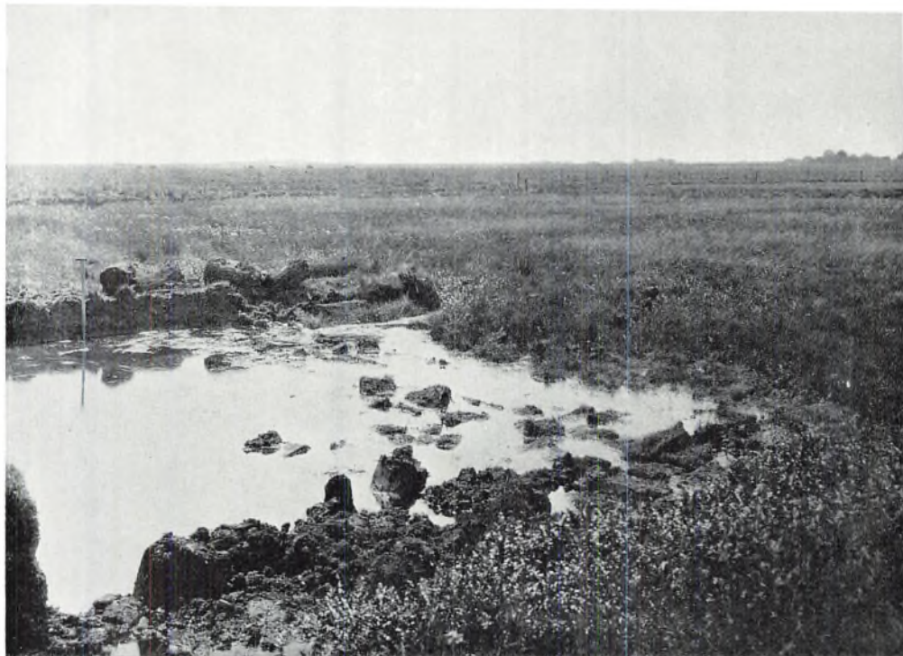
„Olmersvolden“s palisadeværk tværs over mosen på Almstrup Mark. (72)
