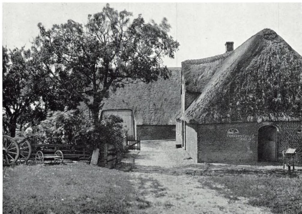
En tolænget marskgård i Rudbøl. (16)
