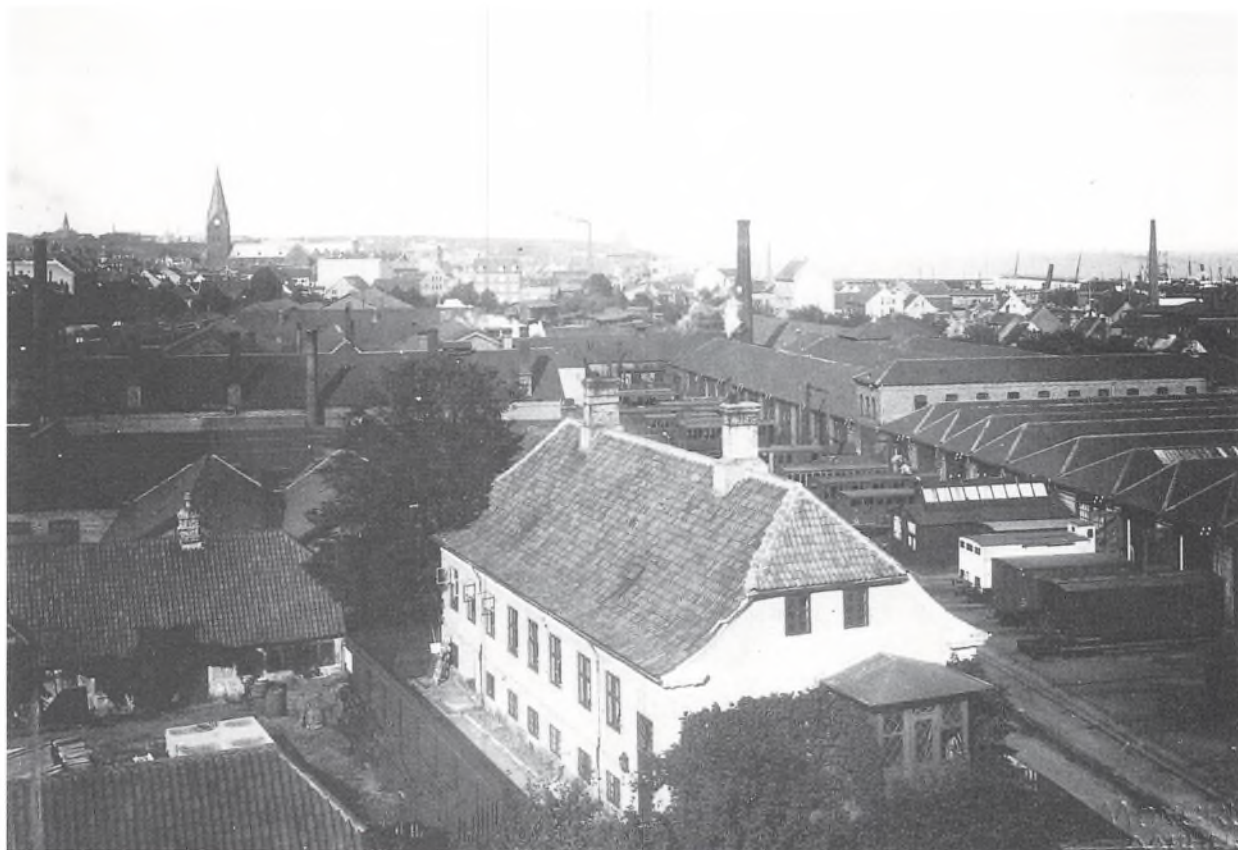
Udsigt fra syd over værkstedsterrænet omkring 1910. I forgrunden Jægergårdens hovedbygning, nyopført i empirestil med gule mure og sort tag i 1833. Som det ses, var gårdens haveanlæg mod Spanien allerede taget i brug til vognværksteder. Selve gårdspladsen og kolonihaverne vest herfor blev inddraget til nybyggeri kort efter gårdens nedrivning 1910.
