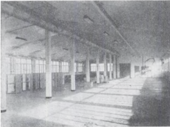
Vognværkstedbygningen ved Spanien. Værkstedsløkke på 3. sal.
