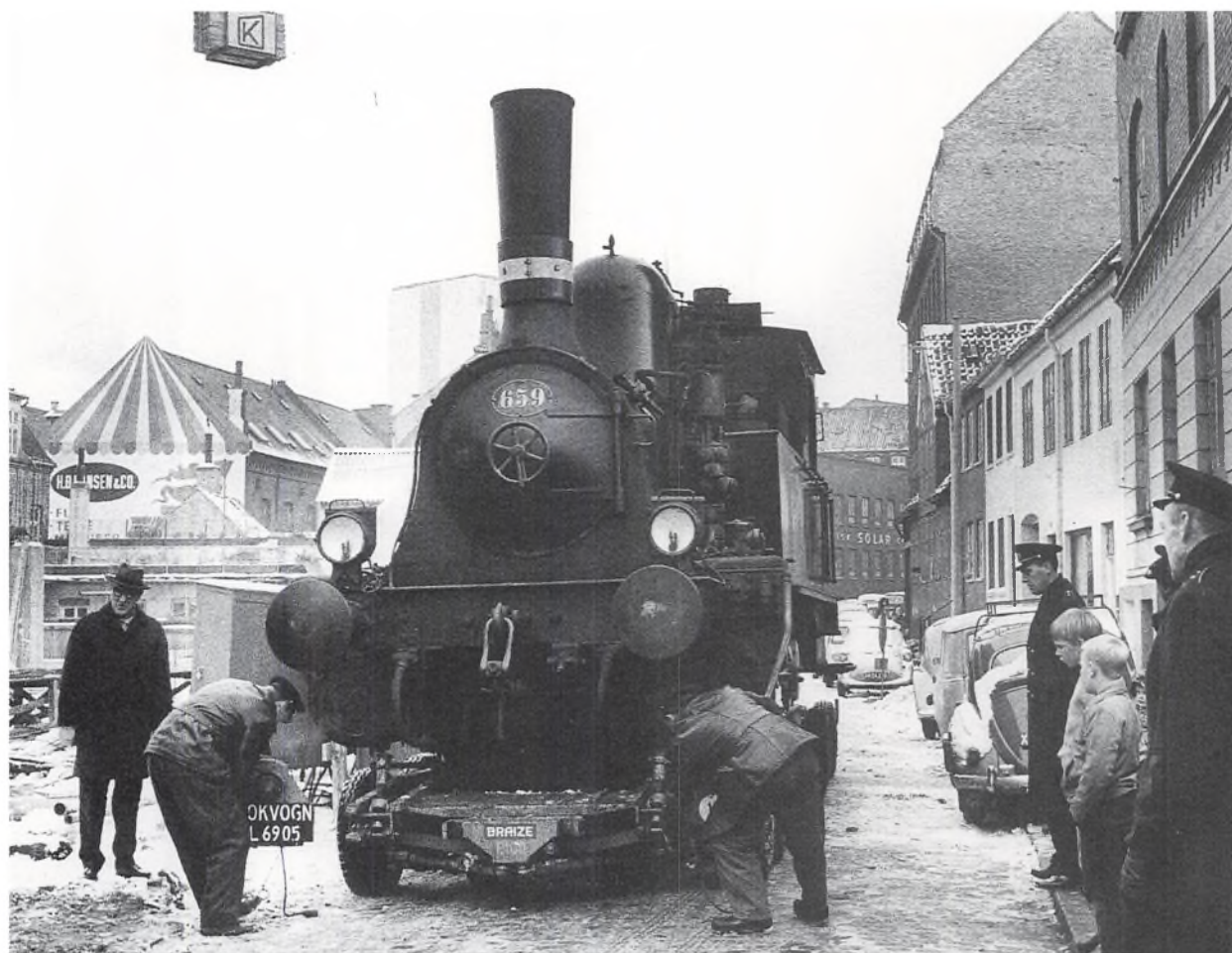
Garveriet krævede damp, og da en dampkeddel var brudt sammen en novemberdag i 1965, fandt man på den utraditionelle løsning at leje dampkraft hos DSB. Her ankommer lokomotivet på en blokvogn.
