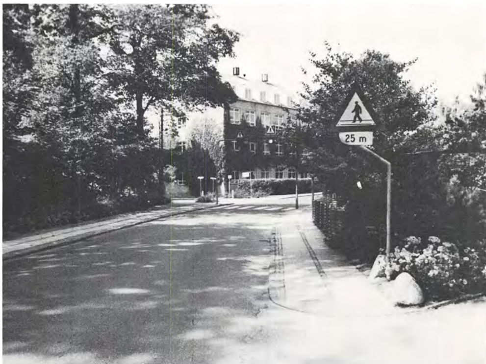
Juli 1977 med skolebygning, opført 1939 som Statsskolens laboratoriebygning.
