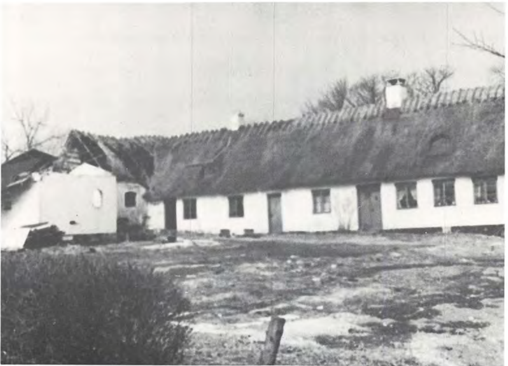
Løbjerggård ved Kajerød Torv før nedrivning 1964.
