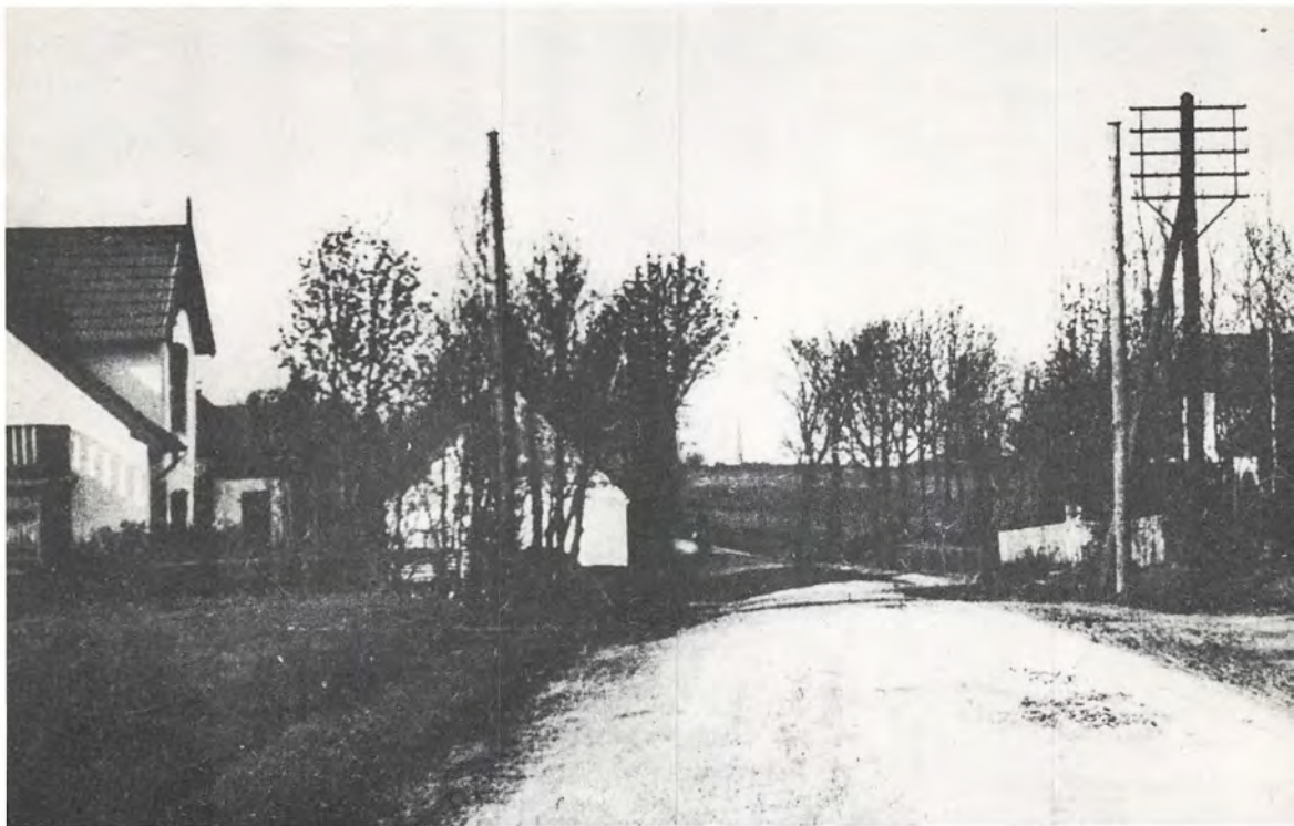
Bistrupvej ved Hegnsvej ca. 1920 (indkørsel til Bistrup Hegn). Bag træerne til venstre Dybækhuset og Dybækrenden.
