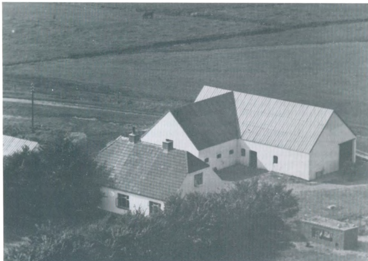
Vester Morre er et fint eksempel på den type statsejendomme, som opstod i 1930'erne: Et frilliggende stuehus og vinkelbygget stald og lade. Vejen bag laden fører til højre hen til Sønder Morre, til venstre til Lille Morre. På marken bagved ses Morre bæk.
