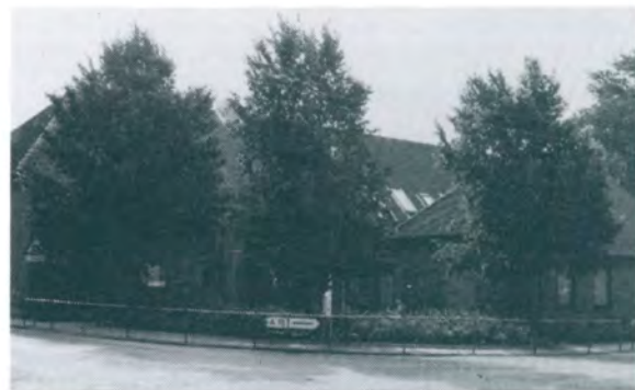
Sognegården ligger længere tilbage på hjørnegrunden end samlingshuset, der blev revet ned i 1953. Sognegården rummer en stor sal ud mod Hovedgaden og en mindre sal bagved.
