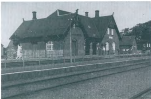
Foruden to spor til persontrafikken har Tvis station et ladespor, som fører hen langs SAJYKAs bygninger.
