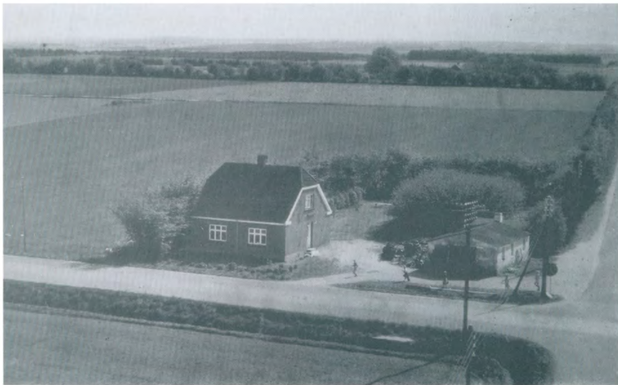
Endnu i 1955 lå Halgård smedie helt ude på hjørnet ved Herningvej og Munkbrovej. Da vejen skulle udvides, måtte smedien vige, og en ny blev opført længere tilbage på grunden.
