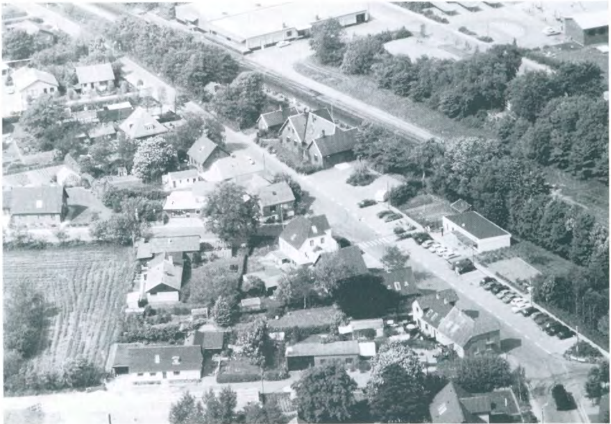
Når der er arrangementer i sognegården, er der brug for den parkeringsplads på Klostervej, som anlægges dér, hvor der før var have til vogterhuset og hvor stationen havde arealer. På Lauralystvej i forgrunden ses det tidligere røgterhus til Lauralyst, mens rækkehusene vest for endnu ikke er opført. Billedet er taget i 1983.
