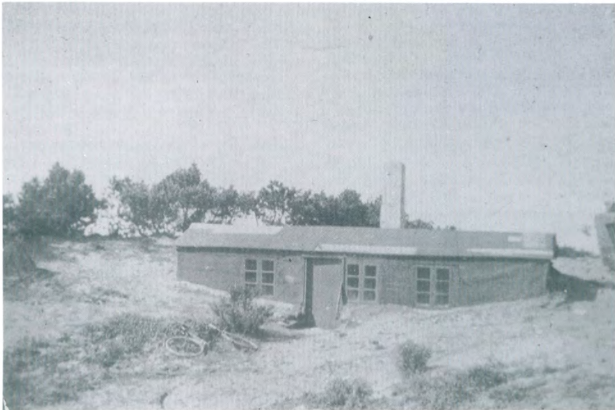
Dette er Jens Christian Jensen Trindmoses hus i plantagen vest for Gl. Tusholt. Det er bygget ind i bakkerne omkring 1920, og her boede han med sin familie til ca. 1930. Billedet er taget engang i 1930'erne, da huset var fraflyttet.
