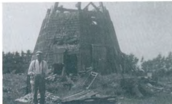
Efter Anden verdenskrig får flere og flere gårde installeret kværne og betydningen af vindmøllerne aftager. Kræ' Møller bliver landmand på linie med andre. Her står han foran møllen, som er under nedbrydning.
