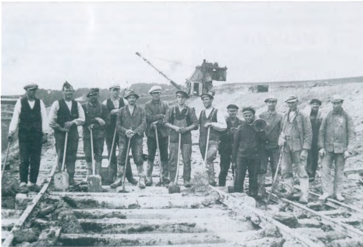
Ved mergelbrydningen var der en overgang beskæftiget 60-70 mand i Tvis. En del tilrejsende arbejdere boede i høsehuset ved Tvis mølle. Også husmænd i sognet tog arbejde i mergellejet og supplerede på den måde de ofte beskedne indtægter fra husmandsbruget.
