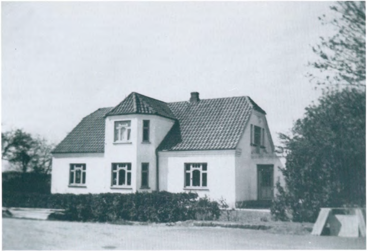
Lerbæks stuehus ligner mere en provinsbyvilla end en landbrugsejendoms stuehus, men måske har bygmesteren skævet til, at det lå så tæt ved byen lige over for sognegården.
