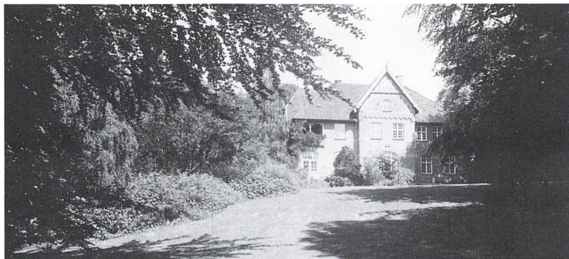
Villa Stettemark, Morlenesvej. Opført 1927. Parkens bevoksning, der stammer fra 1906-25, er rig på sjældne træer, buske og planter. I denne park skal opføres syv nye enfamiliehuse. Fotograferet i juli 1989 af Jens Johansen.
