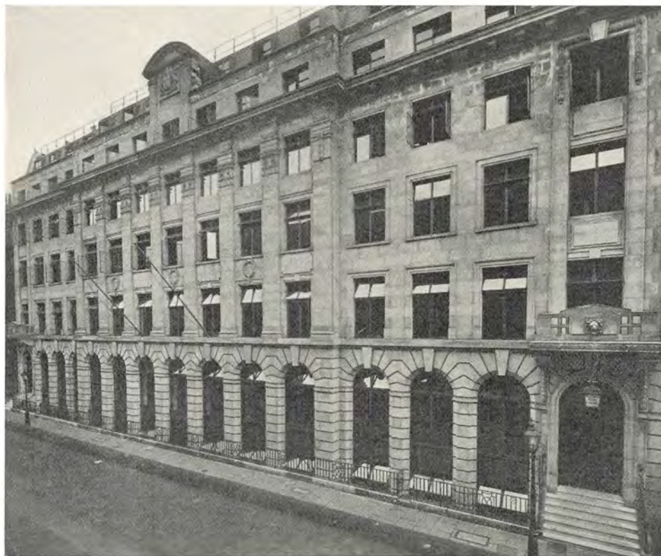
Selskabets Bygning i London.
