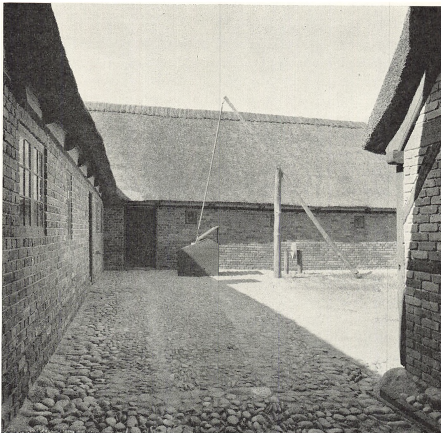
Fig. 5. Gårdspladsen set fra porten i østlængen. I baggrunden vippebrønd og slibesten. I forgrunden karakteristisk brolægning af strandsten på kant. N. Elswing fot. 1968.
