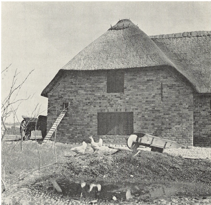
Fig. 4. Nordlængens vestgavl med møddingen i forgrunden. Midt i gavlen renselemme til svinestierne og til venstre stige op til høsehuset over svinene. N. Elswing fot. 1968.
