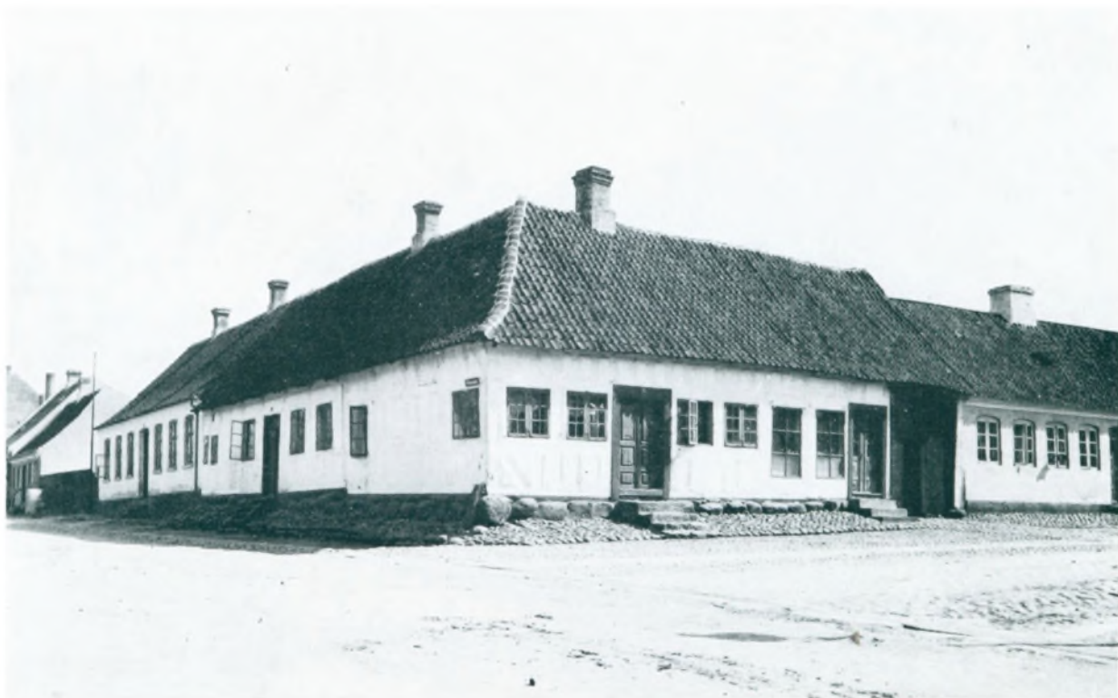
Nr. 118. Vi er her nået til hjørnet af Kongensgade og Prinsensgade, hvor vi ser byens ældste hus. Det ligger på det sydøstlige hjørne. 1914.
