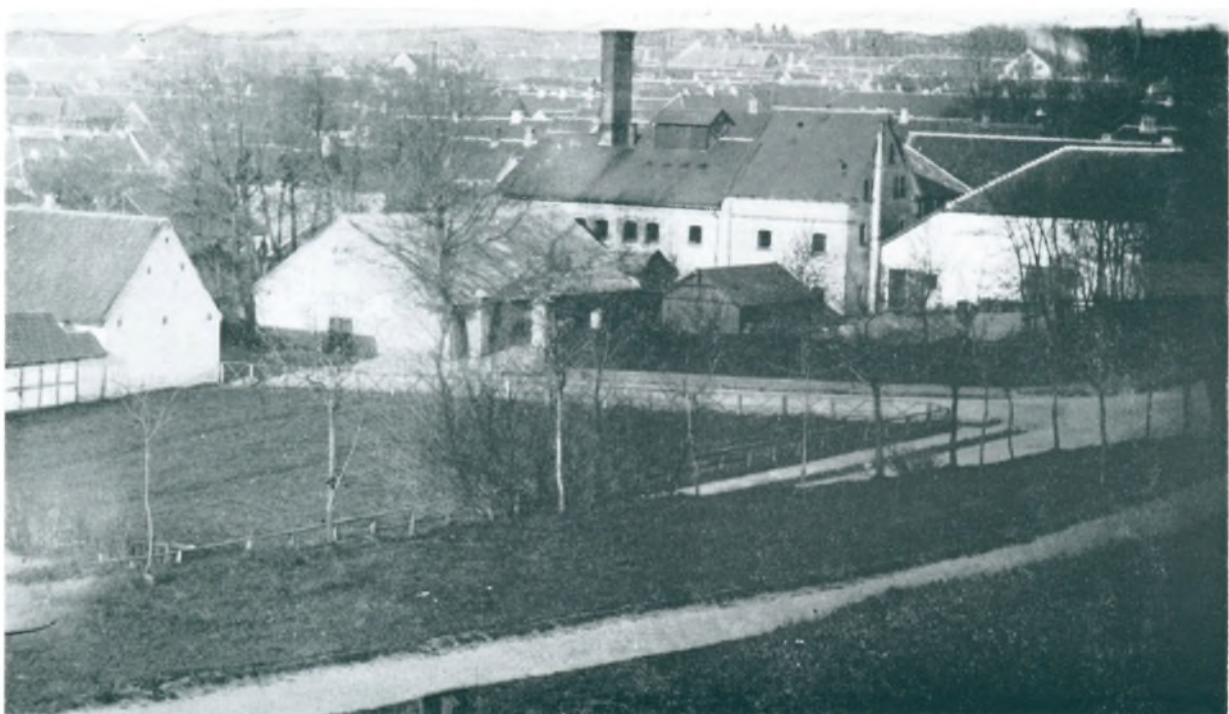
Nr. 116. Vi er gået lidt længere ad Volden og ser her Fæstningsbryggeriet. I forgrunden hjørnet af Kongensgade og Nørrevoldgade. Ca. 1895.
