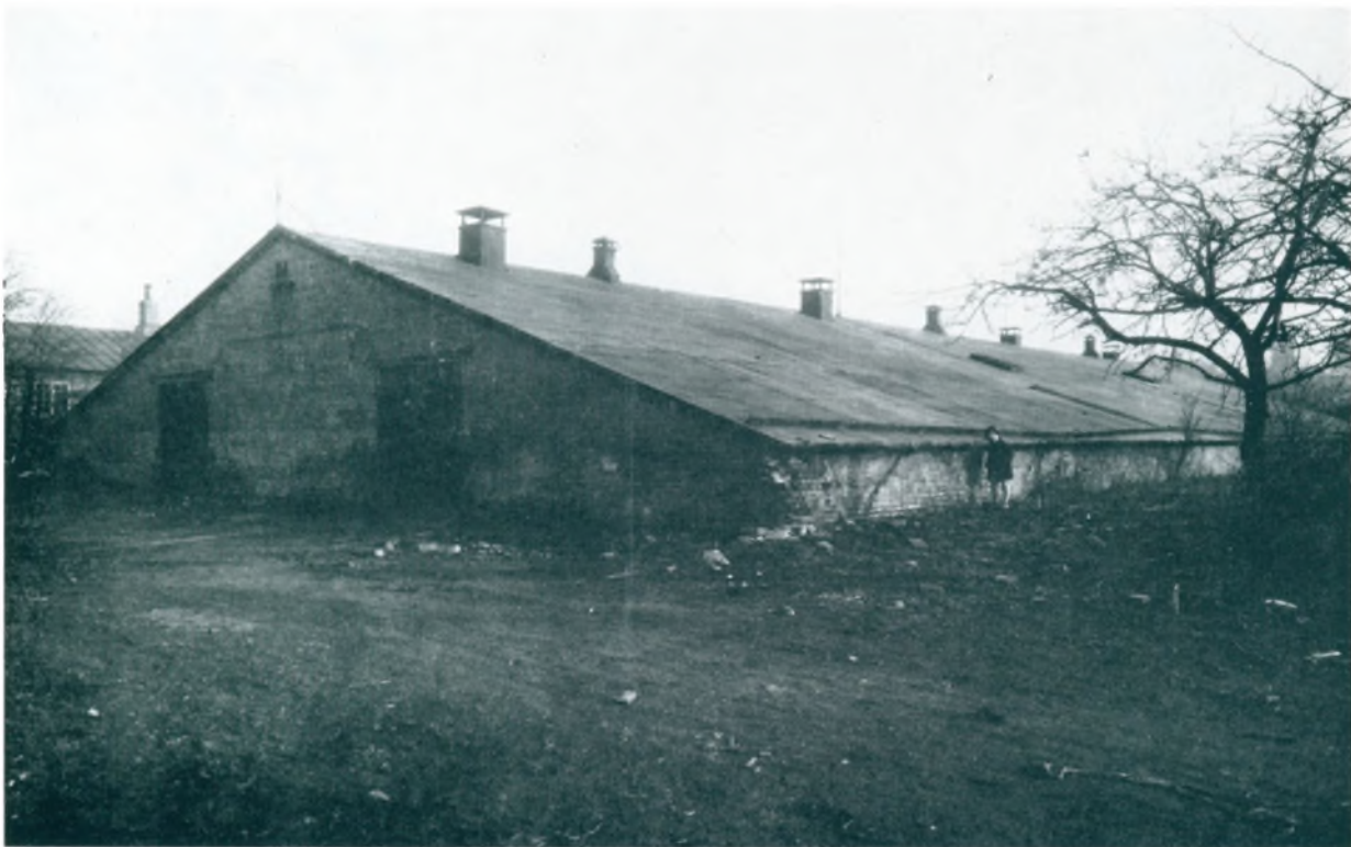
Nr. 124. Petroleumslageret ved Oldenborggade. Opført 1876. En del af bygningen ligger endnu på elektricitetsværkets grund. Ca. 1925.
