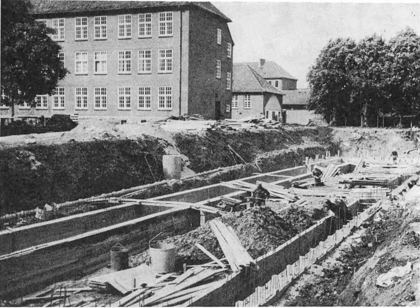
Fundamenter støbes.
