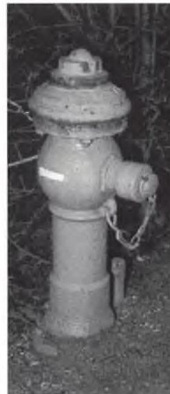
14. 2-tommer brandhane, model 1907, på Concordiavej i Nærum. Ved vandværkets etablering i 1907 blev der opstillet 163 brandhaner af denne model. I dag er der ialt 647 brandhaner fordelt ud over kommunen, heraf 106 stk. af ovennævnte model. Stregerne på siden angiver brandhanens ydeevne. De enkelte brandhaners kapacitet er ligeledes angivet i brandhanekortene, således at man allerede på vej til brandstedet kan vurdere hvilken brandhane man skal foretage udlæg fra for at opnå tilstrækkelig vandforsyning.
