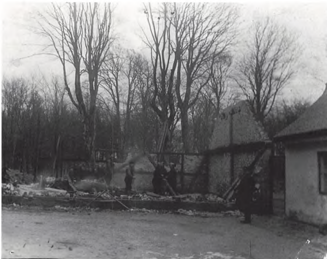
99. Længe til Ørholmgård nedbrændt. På trods af den korte afstand til det stråttækte hovedhus, er det lykkedes at redde dette. Forrest ses brandinspektøren, smedemester Oluf Hansen. Vandforsyningen fra brandhanerne var meget ringe og man måtte derfor foretage slangeudlæg helt ned til Mølleåen.
