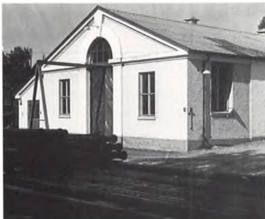
15. Holte Vandværk, Øverødvej, opført 1907. Det var i denne bygning at den første motorsprøjte var stationeret fra 1924 til 1932.
