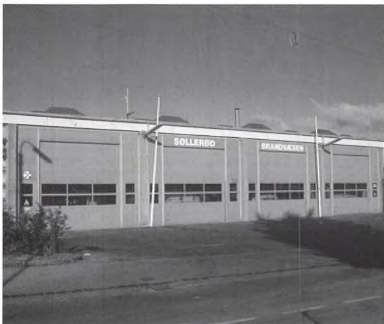
34. Brandstationen på Rundforbivej i Nærum, september 1991.
