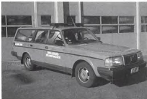
58. P 1 - vagthavendes udrykningsbil. Er opbygget med diverse opslagsværker samt med radioudstyr til kommunikation med skibe, redningshelikoptere samt naturligvis personer og køretøjer på landjorden.
