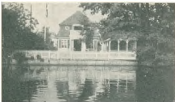
Sommerhuset paa Aahavevej (tidligere Birkevej) 23 set fra Gudena. Aahaven blev købt i 1906, Sommerhuset blev bygget 1928.
