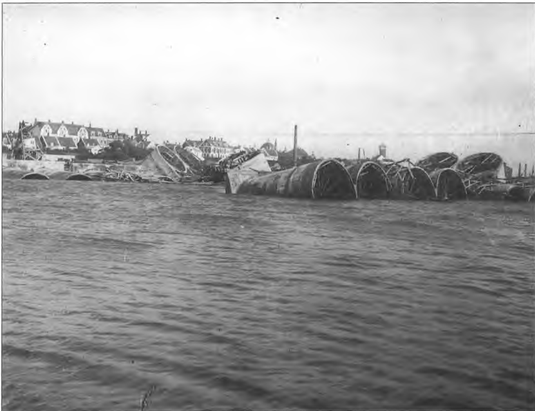
Trafikhavnen under opbygning. I forgrunden ses de væltede sænkekasser. (Foto: Esbjerg Byhistoriske Arkiv)
