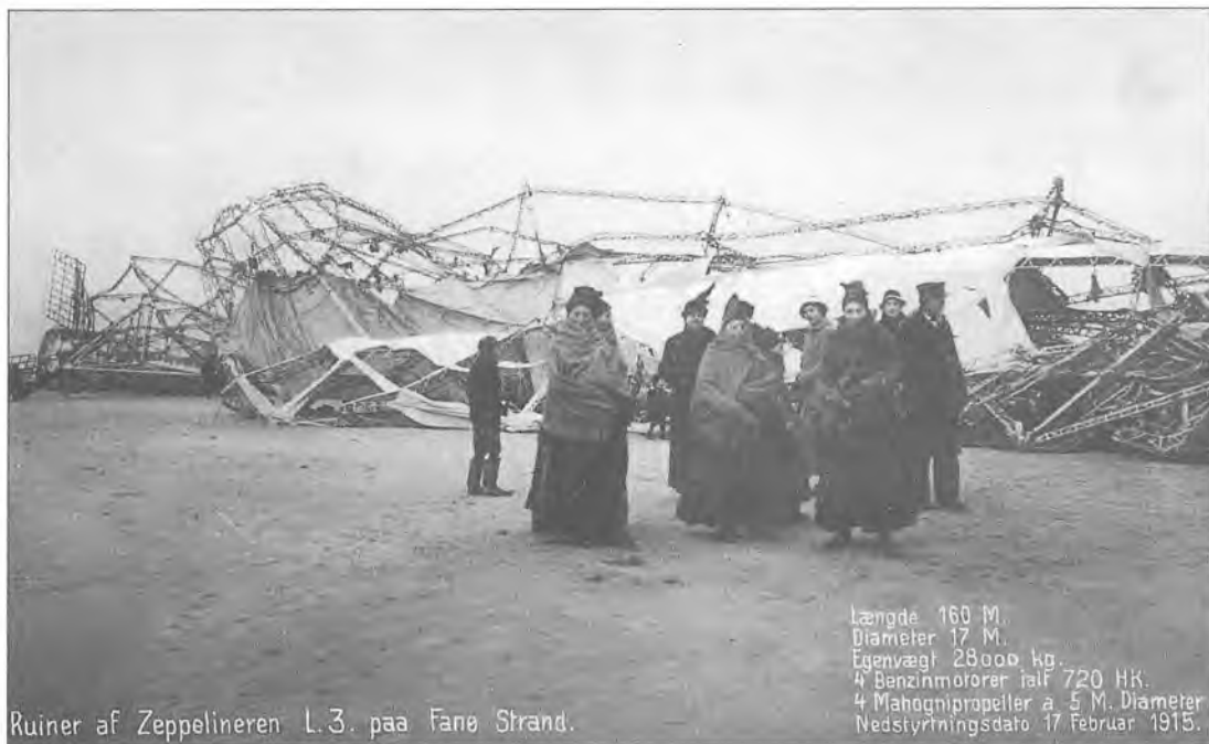
Resterne af tysk luftskib nedstyrtet på Fanø i 1915. (Foto: Esbjerg Byhistoriske Arkiv)
