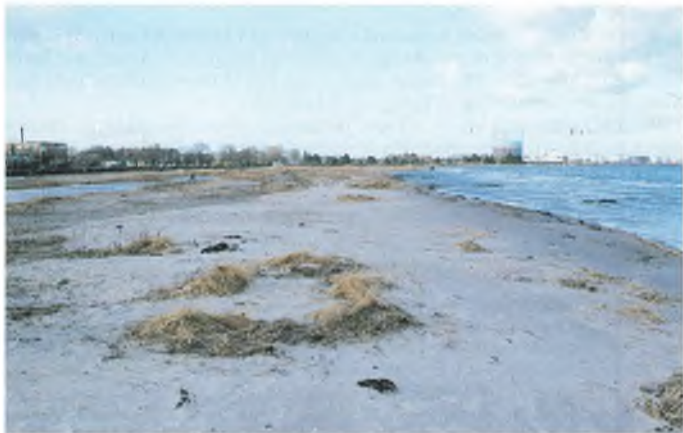
Vinter på Amager Strand – havet skyller ind over spunsvæggen.
