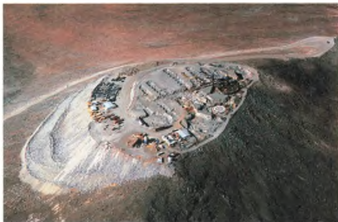
Figur 8: På bjergtoppen, Cerro Paranal, i det nordlige Chile, opfører ESO verdens største teleskop, som består af fire 8-meter teleskoper. Ud over fundamenterne til de fire teleskoper, ses udgravningen til de tunneler, som skal føre lyset til et fælles fokus.
