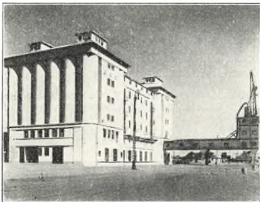
Silopakhus i Esbjerg
