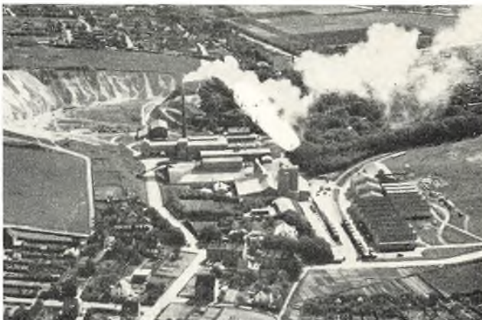
Cementfabrikken Danmark, Aalborg
