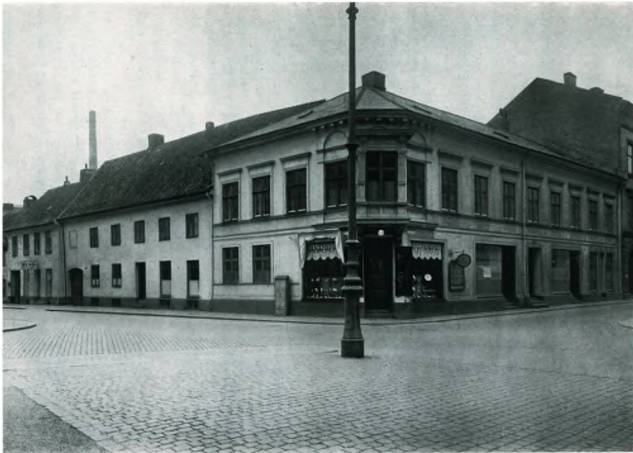
Lorentz Berghs gård vid Kalendegatan och Kyrkogatan. Hörnhuset (nr 358) är restaurerat under 1800-talet, men huset vid Kalendegatan (nr 359) är i sitt ursprungliga skick. Längst till vänster synes huset nr 360, som Anna Maria Bergh bebodde under de sista åren av sin levnad, och som efter hennes död tillföll dottern Dorothea.
