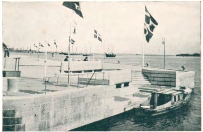
Parti af Langeliniekajen, udført af Firmaet.
