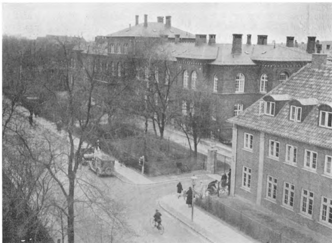
Københavns Amtssygehus paa Nyelandsvej.
