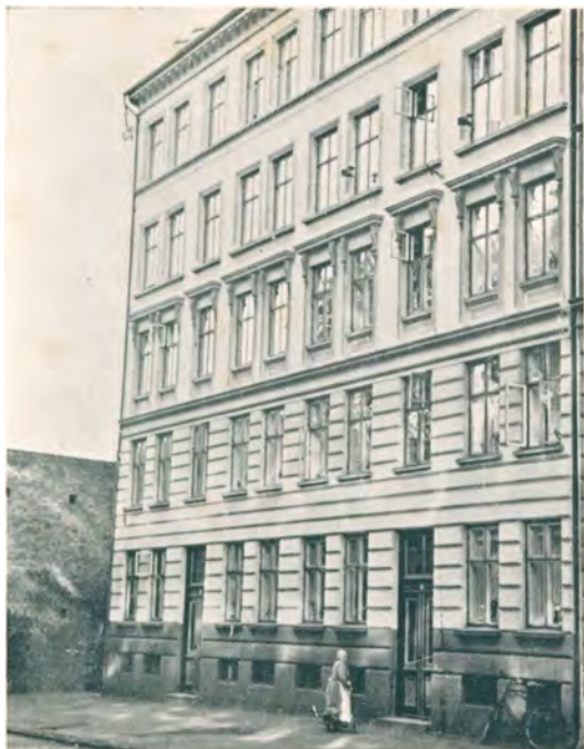
Ejendommen paa Franckesvej 6—8.
