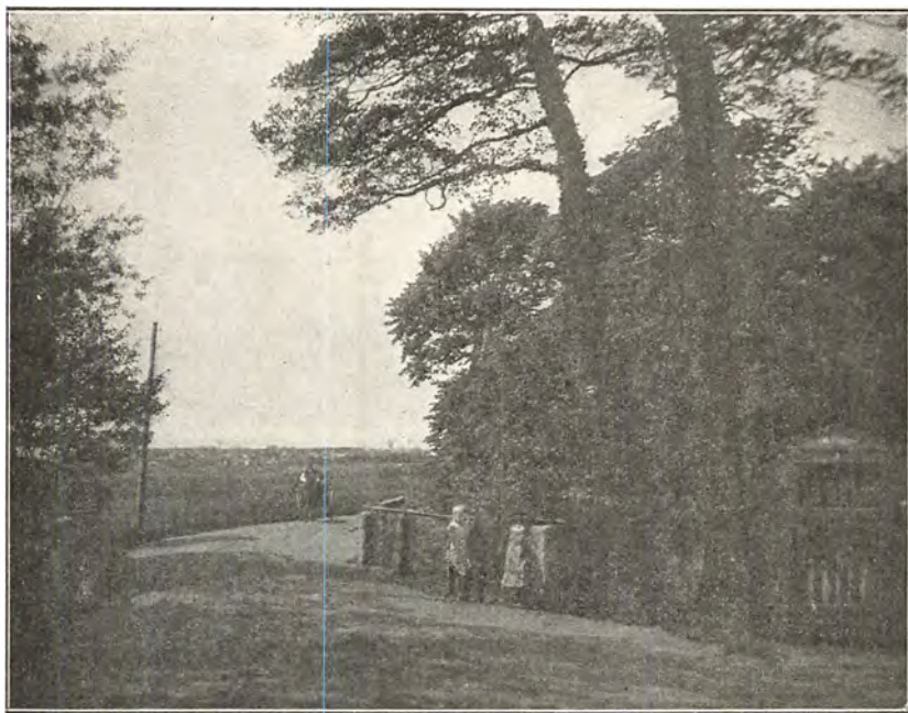
Havnevej. Broen over Shovbækken og østre Shovlaage (for 1907).
