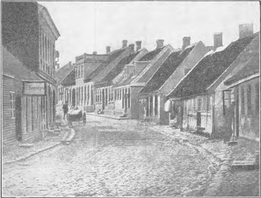
Nørregade i 1870erne. (Til venstre Svanbergs Hus med 2 Etager. Yderst til højre Peder Ravns Hus. Rendesten tværs over Gaden.)
