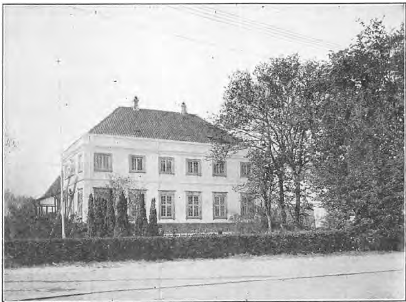
Gl. Skivehus. Facade mod Gaden 1919.
