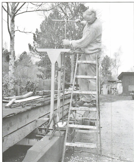
Boring med håndkraft af hul til »ladestokken« - akslen, der går igennem vingen og styrer åbning og lukning af jalousierne.
