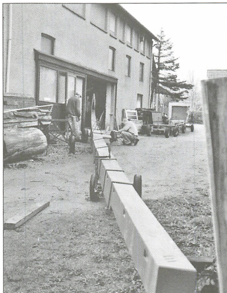
Den færdige vingearm køres ud af værkstedet. Læg mærke til vingens bue.
