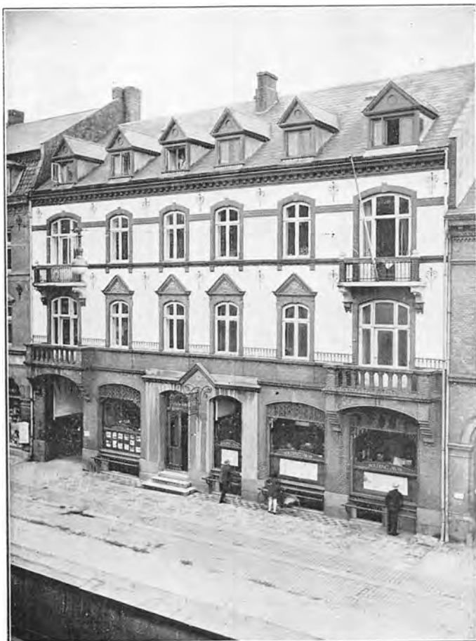
»Jydske Tidende« (»Kolding Avis«) Bygning Jernbanegade 46
