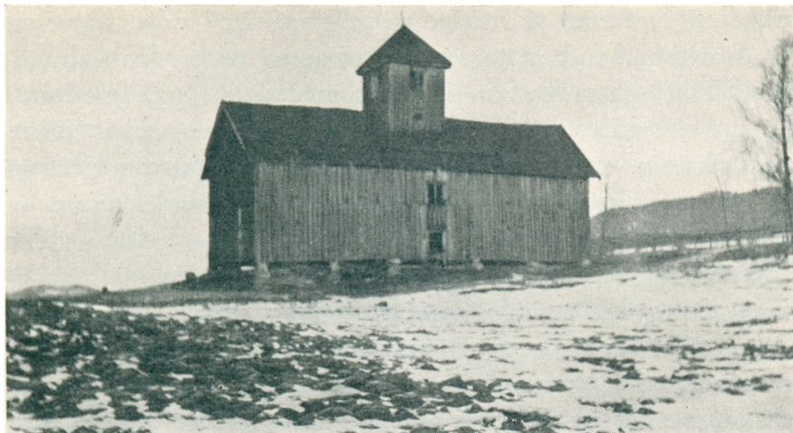
Den tidligere ladebygning med utsiktstårn.
