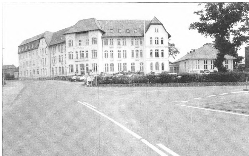
Gigthospitalet efter ombygningen. Til højre ses den nye køkkenbygning.
