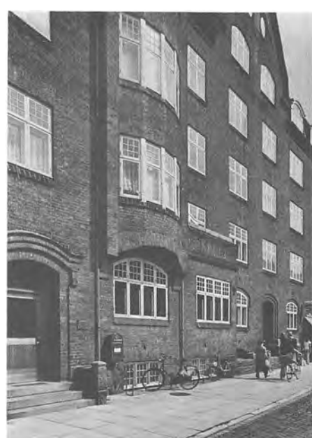
Karnap med hvælvet underside, Ingerslevs Plads 2-4.
