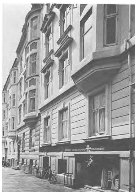
Pudsede karnapper hvilende på udkraget murværk, Hendrik Pontoppidans Gade.
