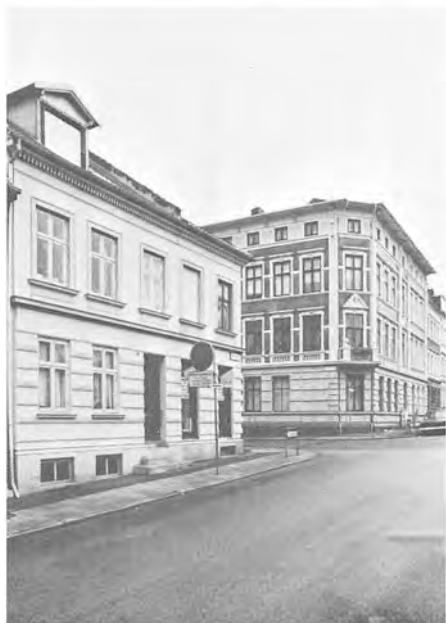
Bülowsgade 29, 29 A, 31 og 33
