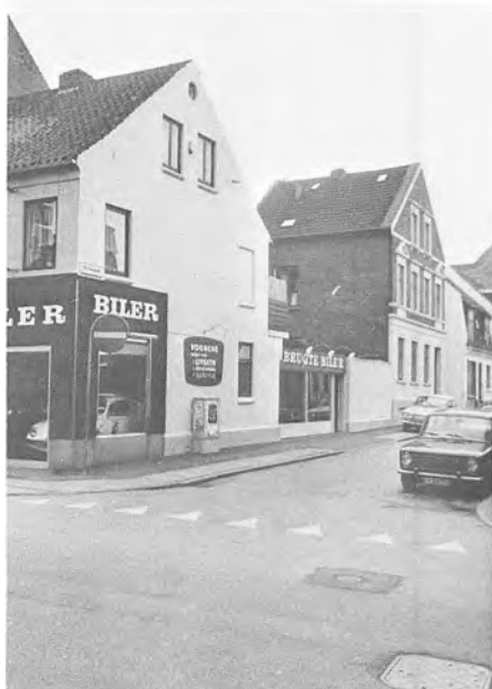
Montanagade 1 og 1 A
