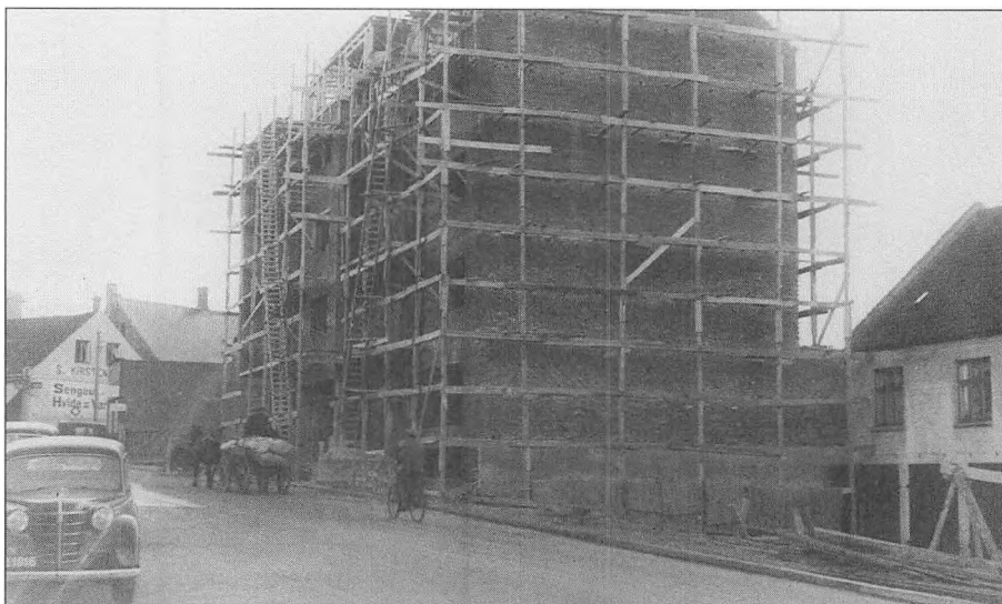
Østergade nr.13 under opførelse 1939.
