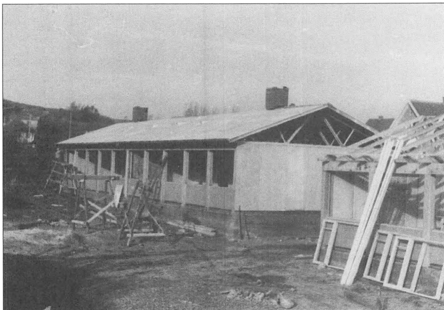
Et "Silkeborg-hus" under opførelse.
