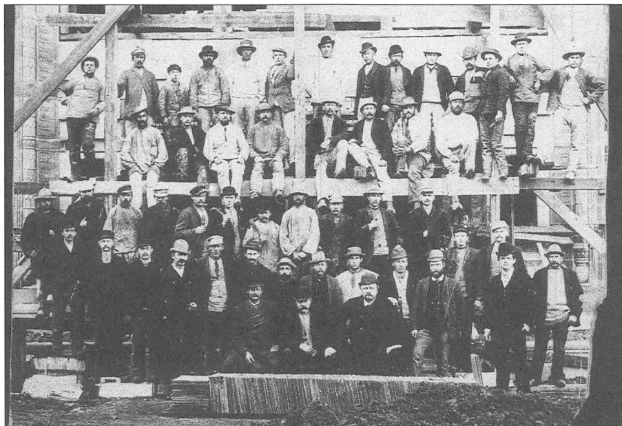
Byggesjak på håndværkerforeningens bygning på Torvet 1895-96.
