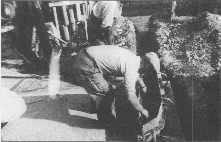
Autoværn støbes på pladsen i Lysbro.
