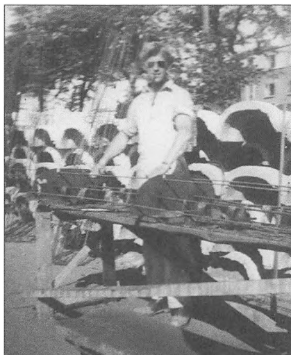
Novi Sørensen gør klar til støbning af fjernvarmerør på Dansk Auto-Værn i Lysbro midt i 1950'erne.
