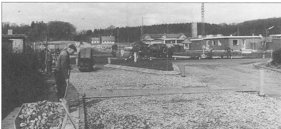
Ringvejsarbejde omkring 1960. I baggrunden skimtes Vester Kejlstrup.
