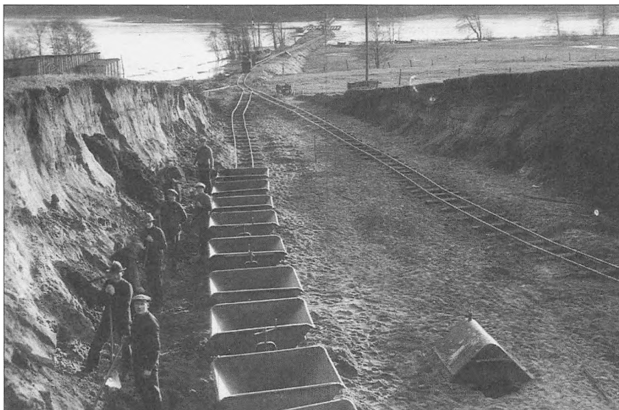
Fast forbindelse til Balle. Kærsgaardbroen under opførelse 1928.
