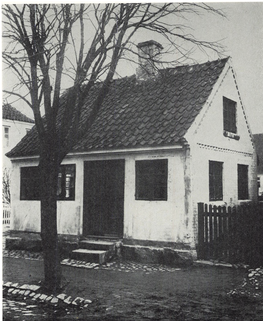
40 - Den gamle accisebod, der lå ved indkørslen til byen, nedrevet ca. 1920.
