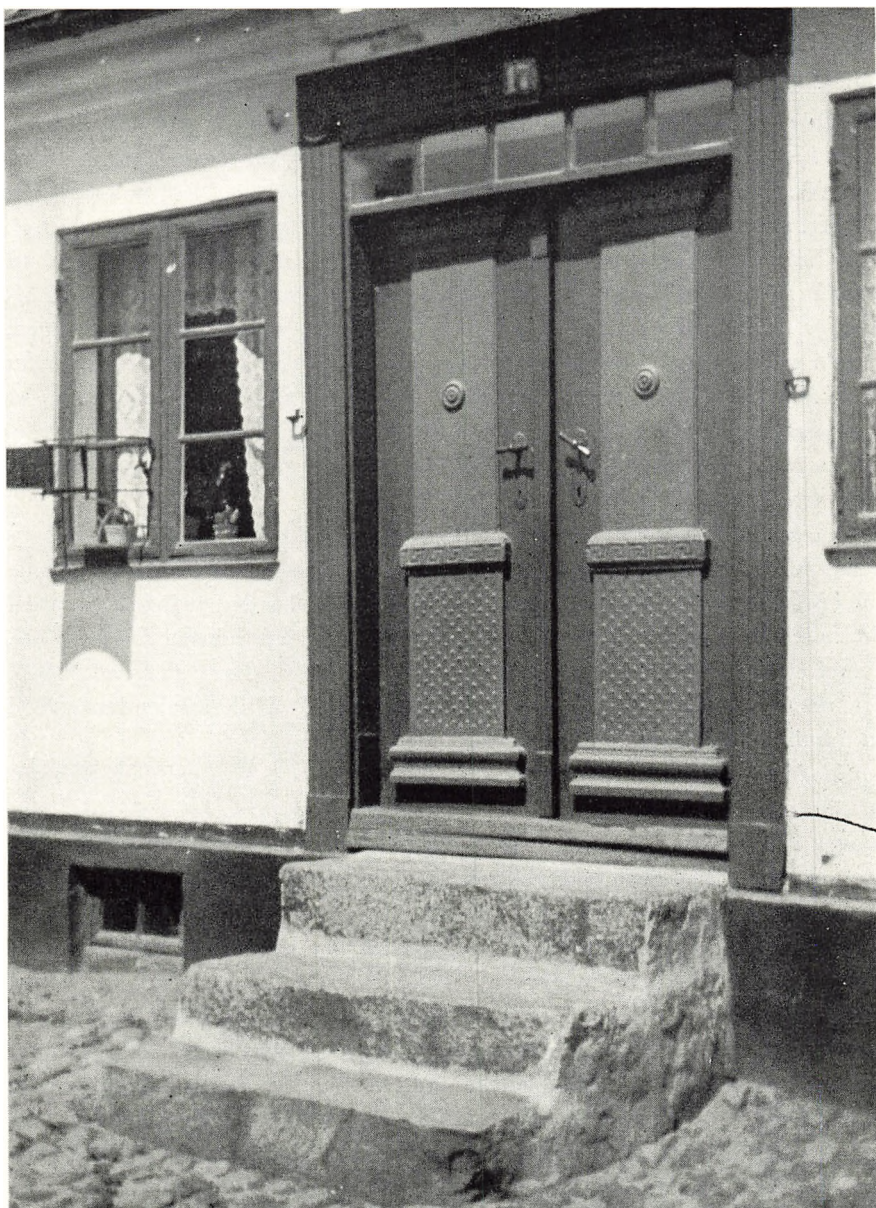
103 - Gadedør med ala greque udskæring i garvmester Brochs ejendom i Sct. Annagade.
