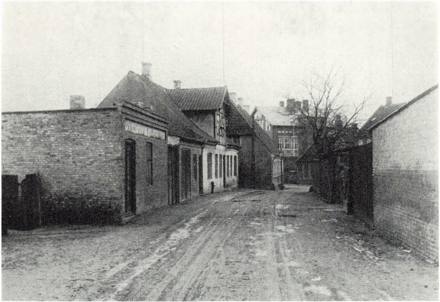
79 - Parti fra Teglårdsvej.
