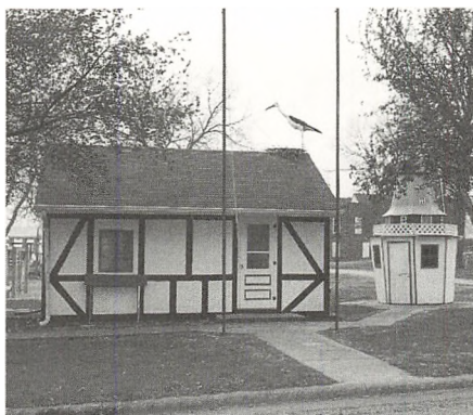
Bondehuset, Kimballton i Iowa
