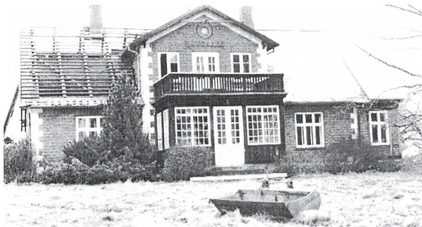
Hovgaardens hovedbygning rives ned i 1988 - sammen med resten af gårdens ca 100 år gamle bygninger. En del af gårdens jorder blev herefter bebygget med etagebyggeri og rækkehuse.
