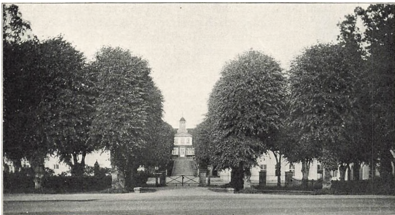
OPKØRSLLEN TIL SORGENFRI SLOT (Fotografi)
