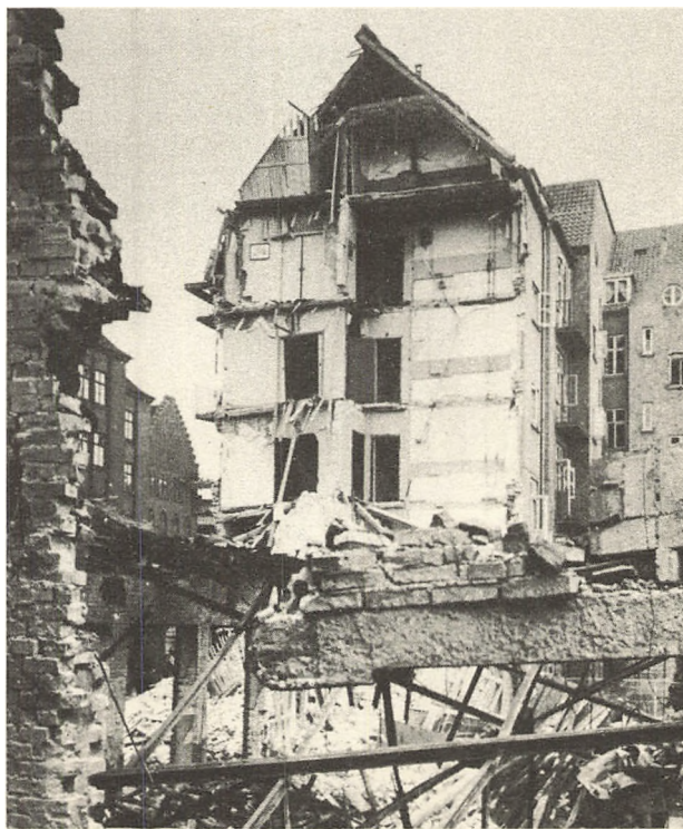
Fra Aarhushallens Scene ser man gennem de sprængte Mure hen over Ruinerne af Caféen og den sammenstyrtede Gavlf af Huset i Sct. Knudsgade.
