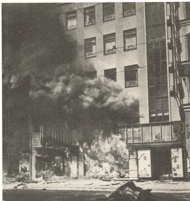
Den store Bulldog-Bygning er sat i Brand og vil snart være en rygende Ruin.
