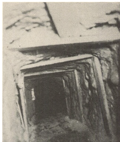
Tunnelen under Jorden, som \frac{3}{4} Meter høj og bred og afstivet med Brædder, blev gravet fra Barakken ud til Friheden uden for Pigtraads-hegnet — ialt en Strækning paa 19 Meter.
