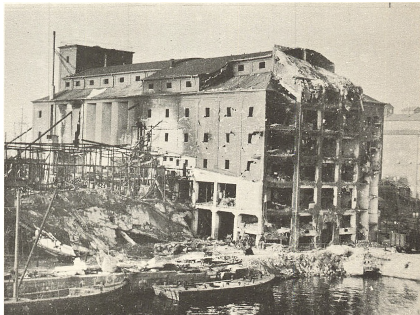
Kornkompagniets Silo, hvor den høje Del blev delvis ødelagt, den lavere Del fuldstændig hærget.
