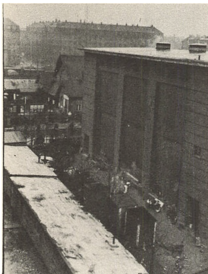
Transformatorstationen ved Lygten, ved Siden af Slangerupbanen, som Bopa har bombet.
