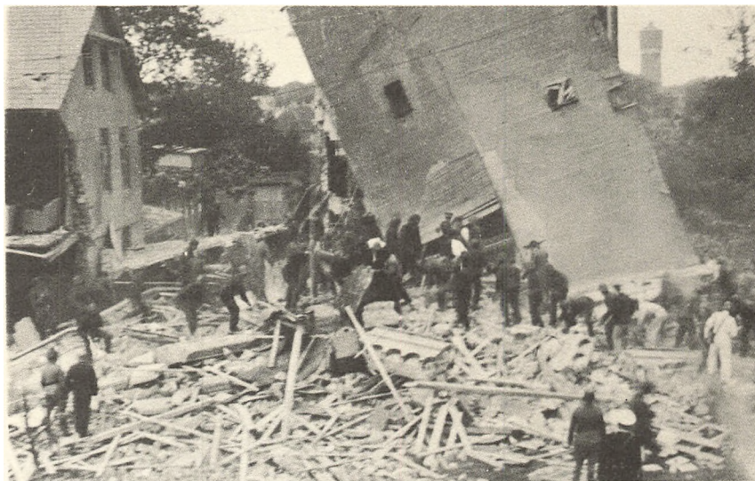
Ved Oprydningsarbejdet mellem de bombede Huse i Jernbanegade i Tønder.
