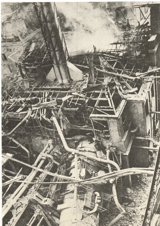
Den store Maskinhal og Kedelrummet paa Tuborg efter Bombingen.
