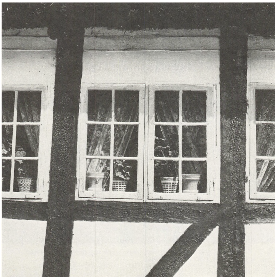
Fig. 31. Eksempel på vindue med to seksrudede rammer, anbragt i bindingsværk med gennemstukne bjælketappe. Det er den almindeligste gamle vinduestype i danske bondebygninger. Gård i Snave, Dreslette sogn, Fyn (P. M. fot. 1959).
