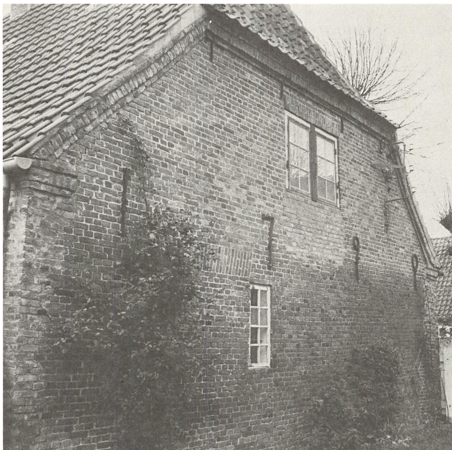
Fig. 9. Årstallet 1790 på en gavl, hvor tallene fungerer som murankre. Eksemplet er karakteristisk for det område mod sydvest, hvor bondebygninger blev grundmuret tidligere end i det øvrige Danmark. Møgeltønder i Sønderjylland (P. M. fot. 1970).
