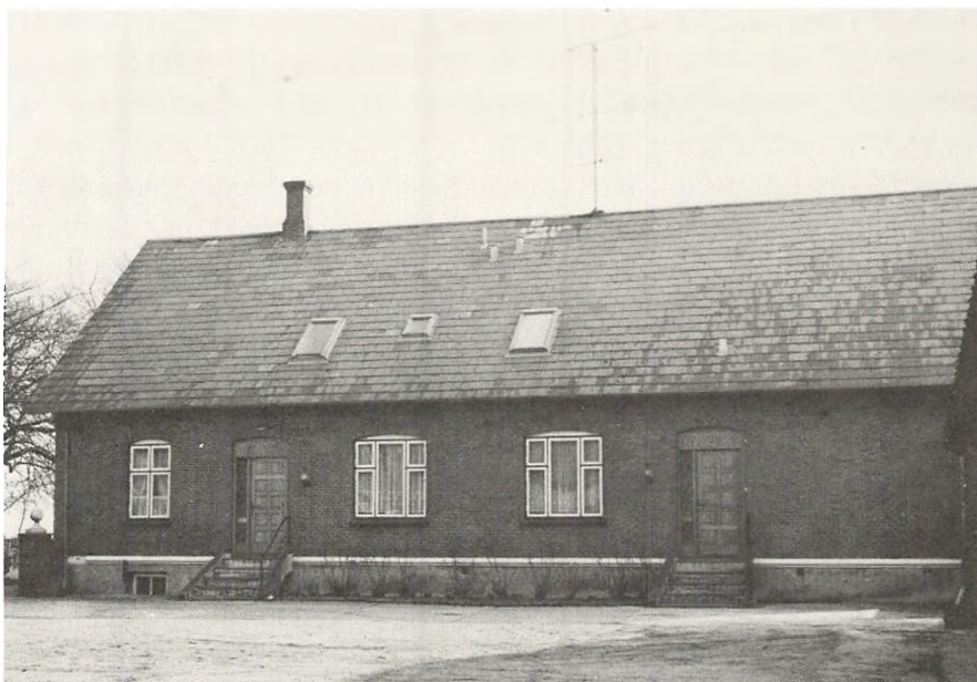
Fig. 34. Det grundmurede gårdstuehus med skifertag har midt for facaden to vinduer med stor midterrudd. I nyeste tid er der indsat ovenlysvinduer i taget, og indgangsdørene er udskiftet. Gården Nielsminde, Melby på Fyn (P. M. fot. 1974).
