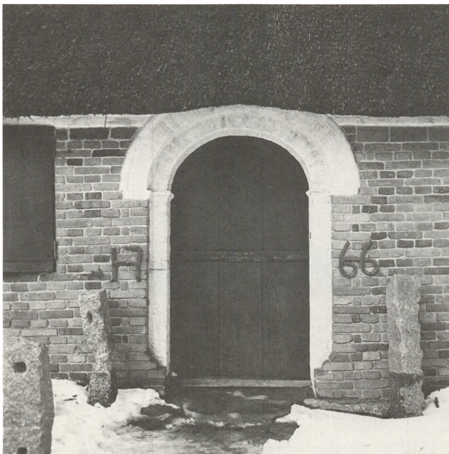
Fig. 12. Årstallet 1766 i jernankre ved indgangsdøren har sandsynligvis snarest noget at gøre med ombygningen af det ældre hus til grundmur. Frilandsmuseet, gårdstuehuset fra Barsø (P. M. fot. 1978).
