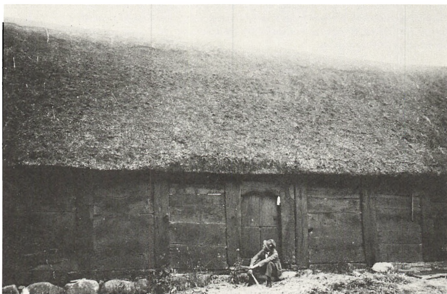
Fig. 22. Det er i nogle af de vandrette bulplanker på dette billede, årringsmålingerne er foretaget med henblik på datering af Frilandsmuseets lade fra Øsby. Her er laden fotograferet på sit oprindelige sted, gården Sparlund i Øsby sogn ved Haderslev (Mogens Clemmensen fot. 1923).
