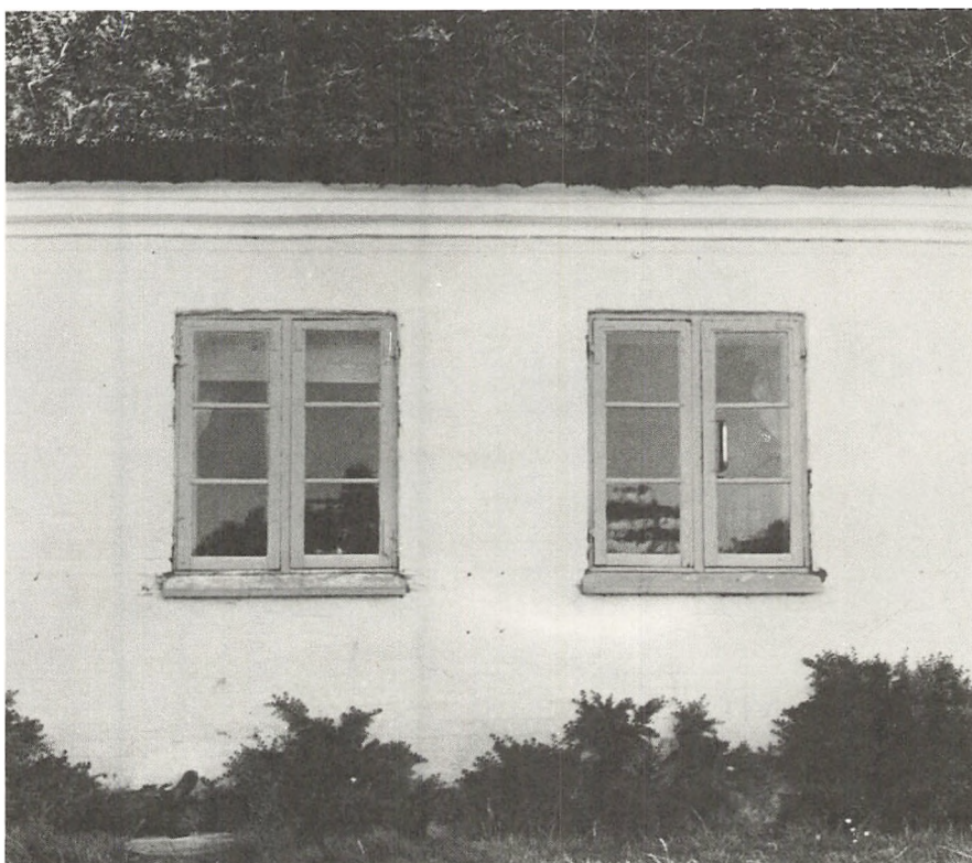
Fig. 32. Eksempel på vindue med to trerudede rammer, anbragt i en grundmuret facade. Gård i Væde, Vævlings sogn, Fyn (P. M. fot. 1958).
