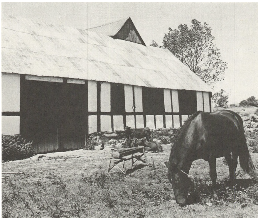
Fig. 30. Man skal ikke på afstand lade sig narre af, at der ikke er stråtag. Der kan godt være bindingsværk under et bliktag. Store Lærkegård, Olsker sogn, Bornholm (P. M. fot. 1959).
