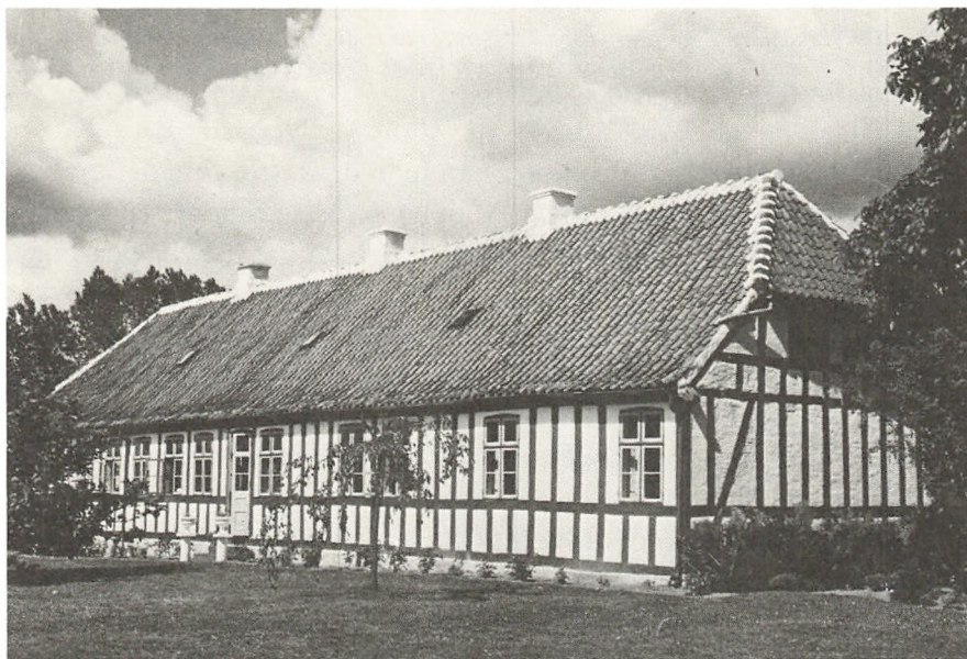
Fig. 33. Dette stor gårdstuehus med tegltag er opført i en yngre form for bindingsværk. Bjælkerne ligger oven på remmen, og der er stor loftshøjde. Vinduerne er indrettet med overvinduer. Vejbygård, Vejby ved Fredericia (P. M. fot. 1951).
