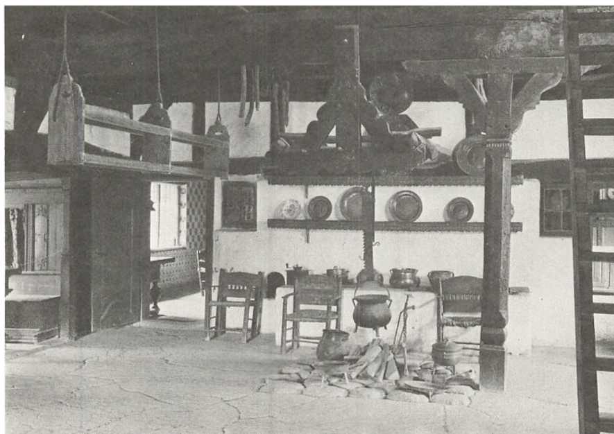
Fig. 24. Øverst i dette billede fra Frilandsmuseets gård fra Ostenfeld i Sydslesvig ses den svære vandrette bjælke, der ligger over ildstedet (Lennart Larsen fot. 1975). I enden af denne bjælke blev den træprøve taget, som den dendrokronologiske datering er baseret på.
