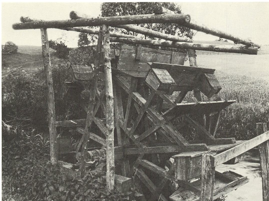
Fig. 2. Samme hjul som fig. 1, her set fra den åbred, hvor hjulet er anbragt. Vandkasserne sidder på hveranden skovl, to på hver. Renderne er forsvundet. H. Zangenberg fot. 1932.
