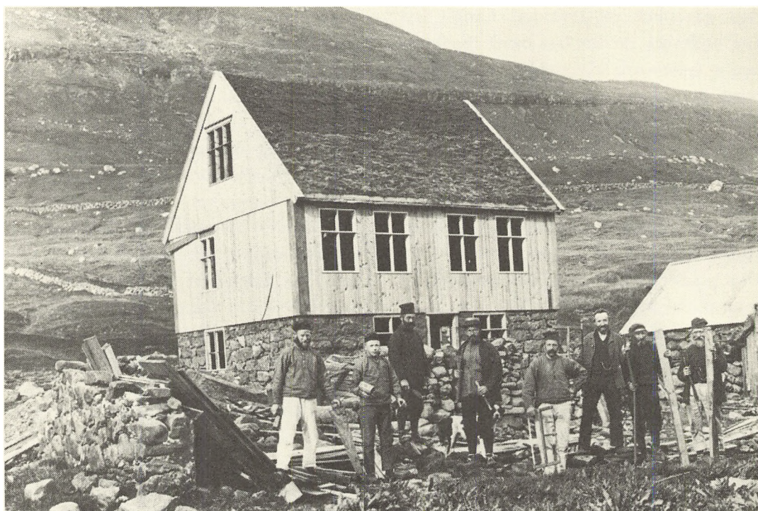
Hus af den nye type under opførsel. Græstørven er kommet på taget, men vinduerne er endnu ikke sat i. Håndværkerne står på resterne af det gamle hus, der er revet ned for at give plads til det nye hus. Ca. 1910. (Føroya Formminnisavni).
