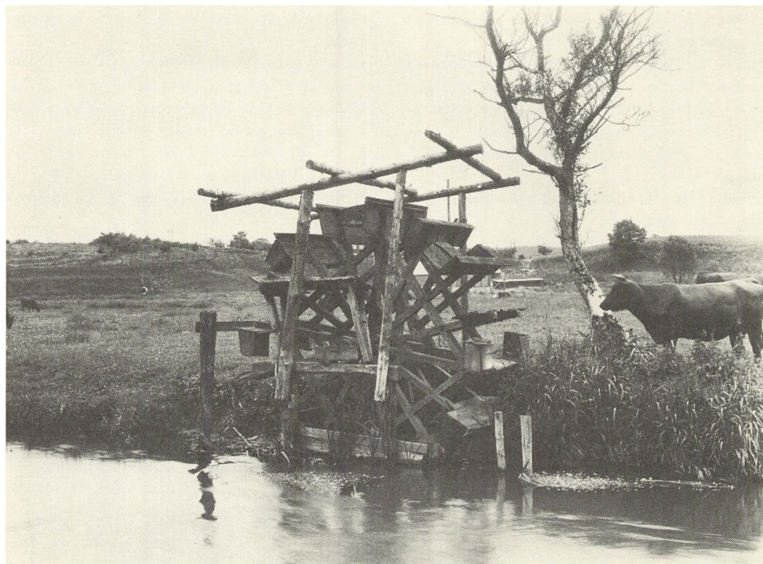
Fig. 1. Strømhjul ved nordre bred af Kolding Å. Strømmen går fra venstre mod højre. I baggrunden anes en gård i landsbyen Ejstrup. Det var dette hjul, der kom til Frilandsmuseet. H. Zangenberg fot. 1932.
