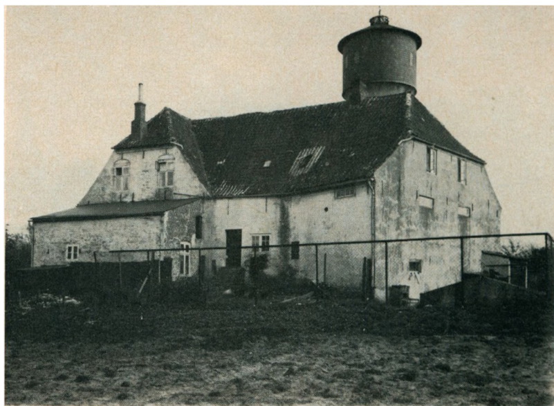
Fotografi af porthuset set fra nordvest. Sammen med de følgende to fotografier optaget af Nationalmuseet ved prøvegravningen 1921.
