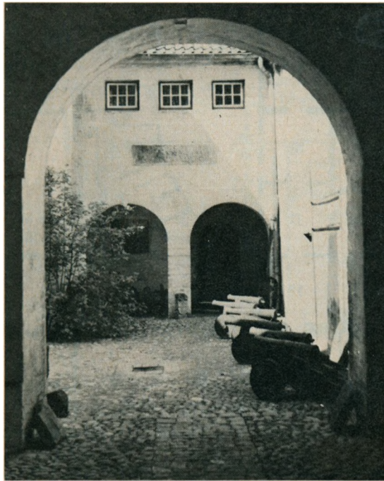
Den vestlige portbue med udsyn over L. Thaysens i 1923 tilbyggede galleri som forbinder kasematterne fra 1530'erne og byfængslerne fra 1811 med den nye museumsbygning. Foran langs porthuset var anbragt borgmester Richtsens paradekanoner fra 1793/94.
