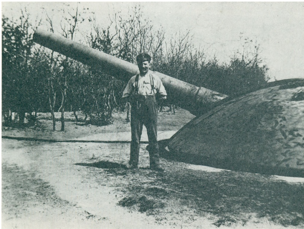
Gammelskovbatteriet havde 10 stk. 24 cm Marine-kanoner i panserskjold. Bemærk, at bevoksningen bag artilleristen er skåret ned af hensyn til skydningen.
